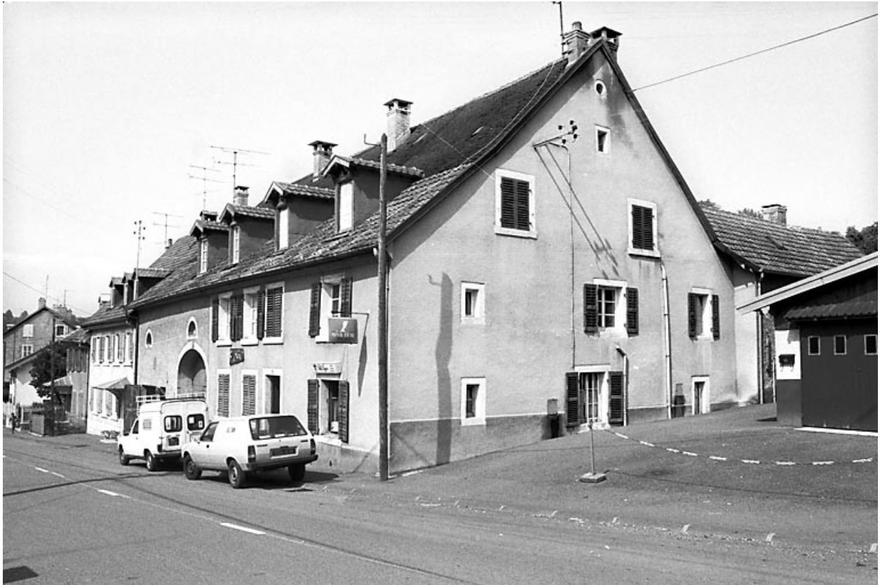
Ferme, rue Charles de Gaulle : vue d'ensemble de trois quarts droit.
