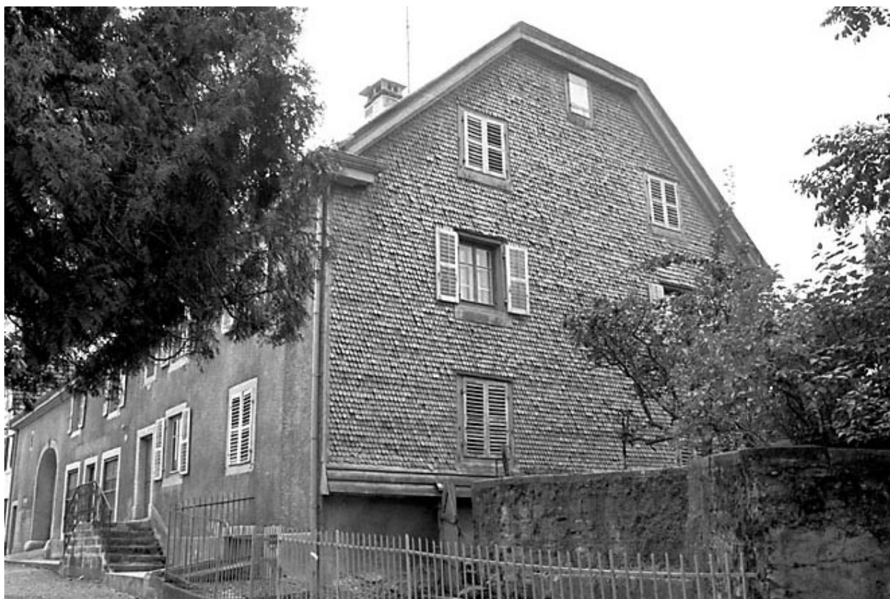
Ferme, 5 rue du Courbot : façades antérieure et latérale droite.
