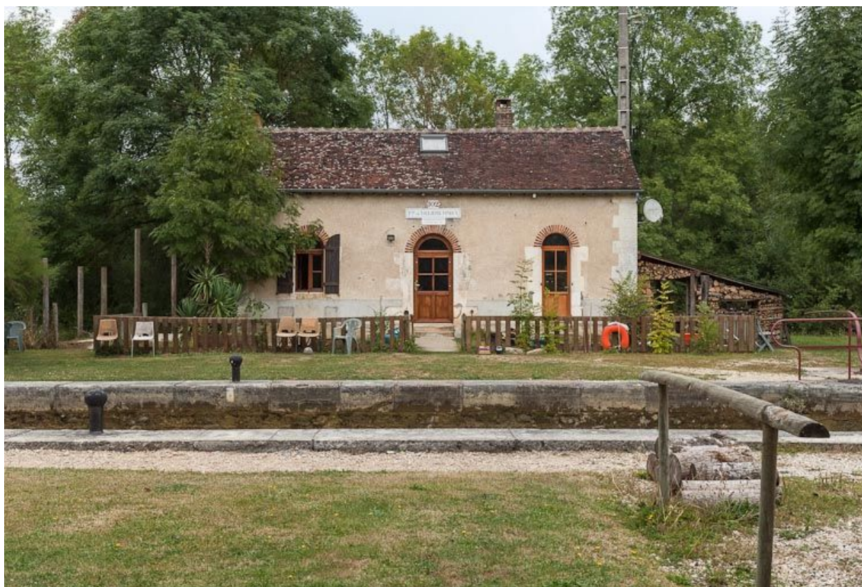
Maison éclusière de face.
