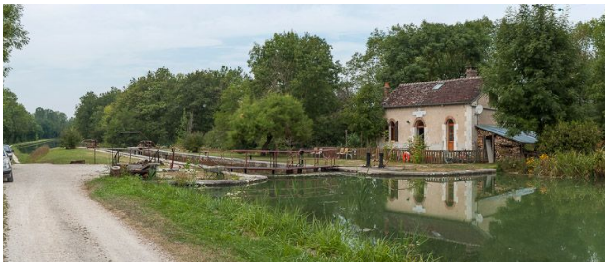
Vue d'ensemble du site d'écluse.
