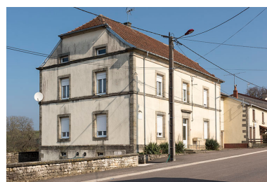
Maison d'école. Vue de trois-quart sud-ouest. Phot. Sonia Dourlot IVR43_20167001213NUC4A
