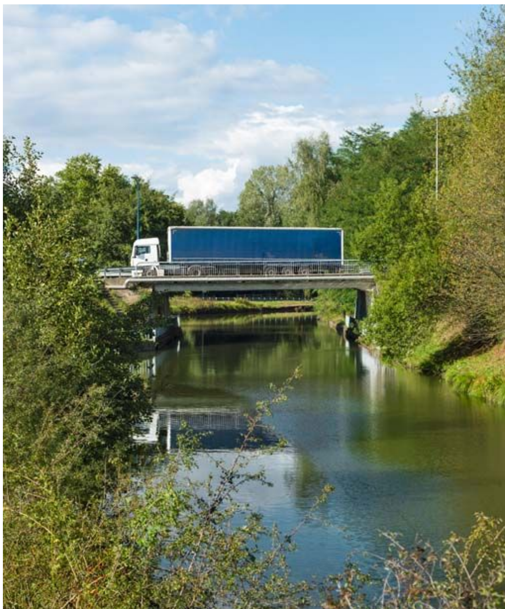
Vue d'ensemble du pont.
