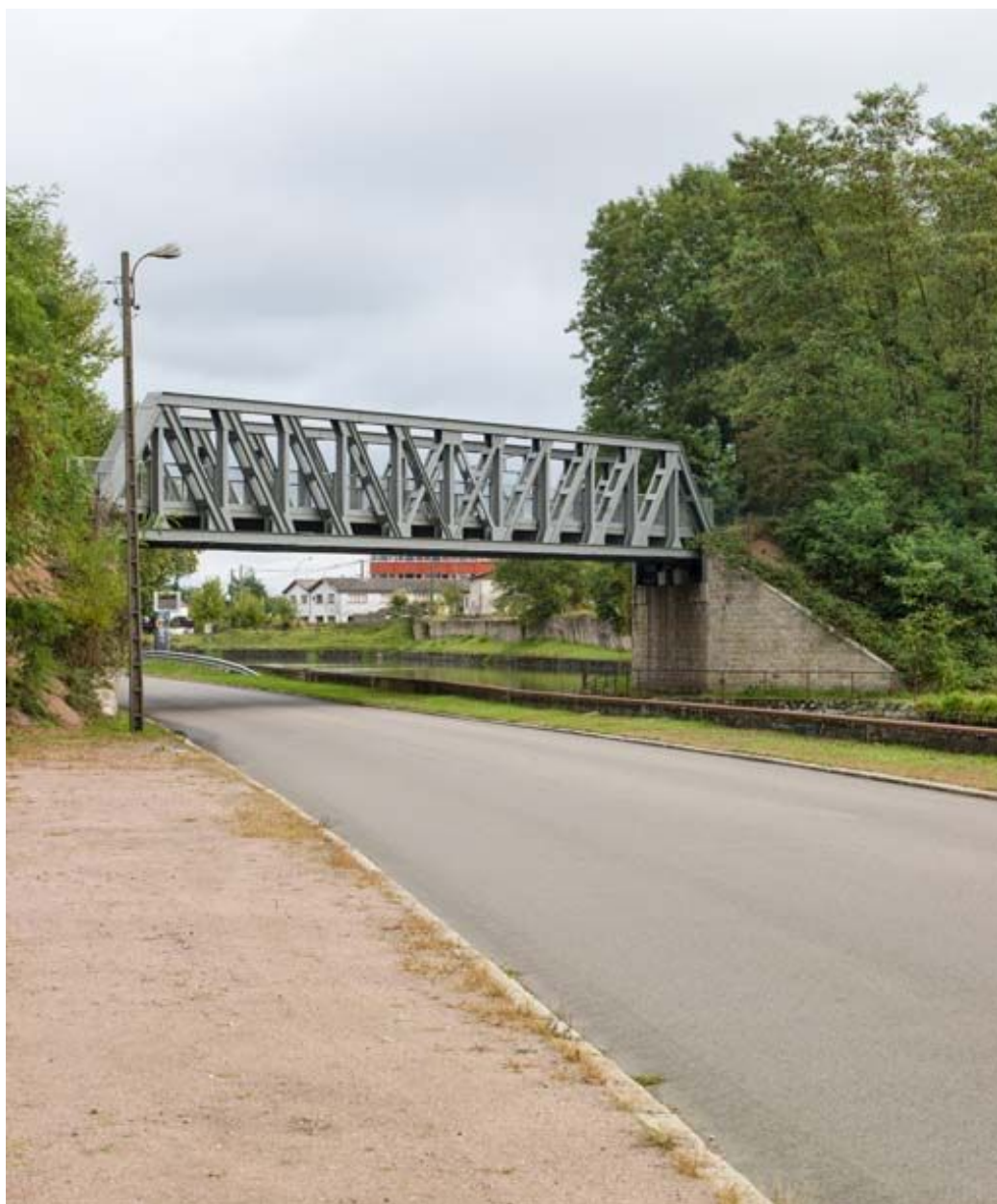
Vue d'ensemble du pont.
