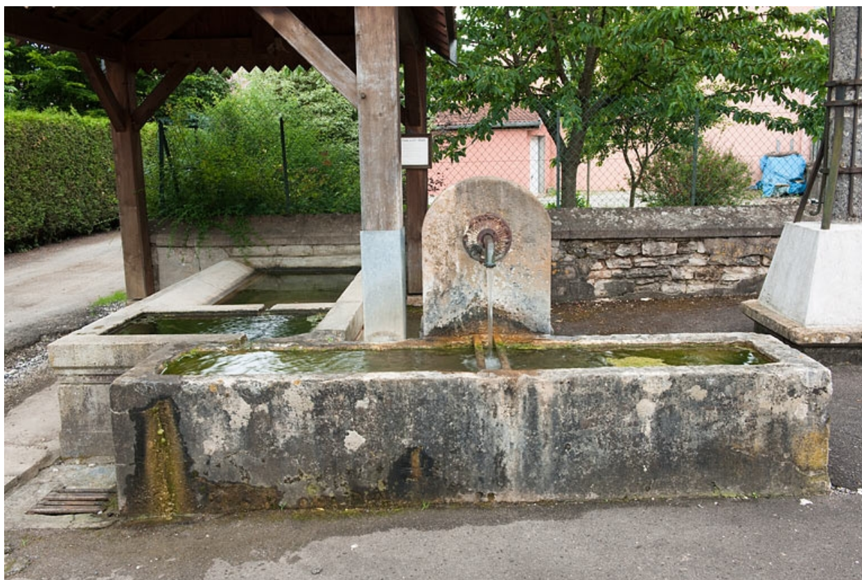
Vue d'ensemble rapprochée.
