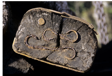
Extrémité d'une traverse avec frettage Delor, esses et clou. Phot. Yves Sancey IVR43_20043900446ZA
