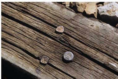
Traverse avec clous. Traverse fabriquée en 1965 (clou à tête carrée avec le millésime 65) par l'atelier Arnaud Beaunartin (Neuf-Brisach, Haut-Rhin) et destinée à être posée avec un écartement de 1,440 m (clou à tête ronde portant le nombre 40).
