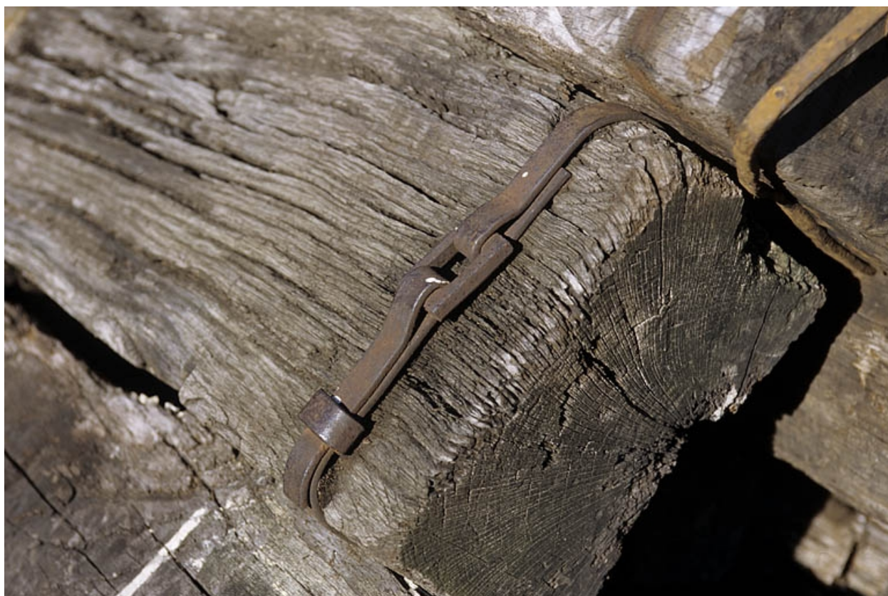
Extrémité d'une traverse avec frettage Delor.
