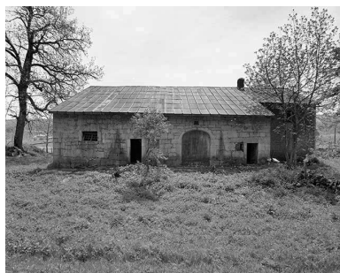
Façade postérieure. Phot. Yves Sancey IVR43_19993900120X
