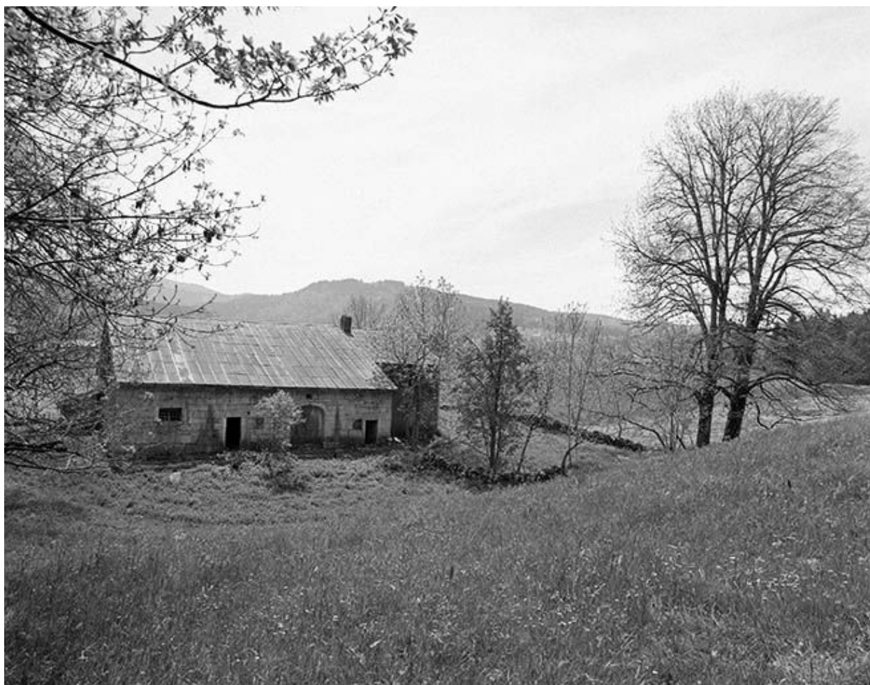
Vue éloignée de la façade postérieure.
