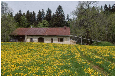
Façade antérieure. Phot. Yves Sancey IVR43_19993900113ZA
