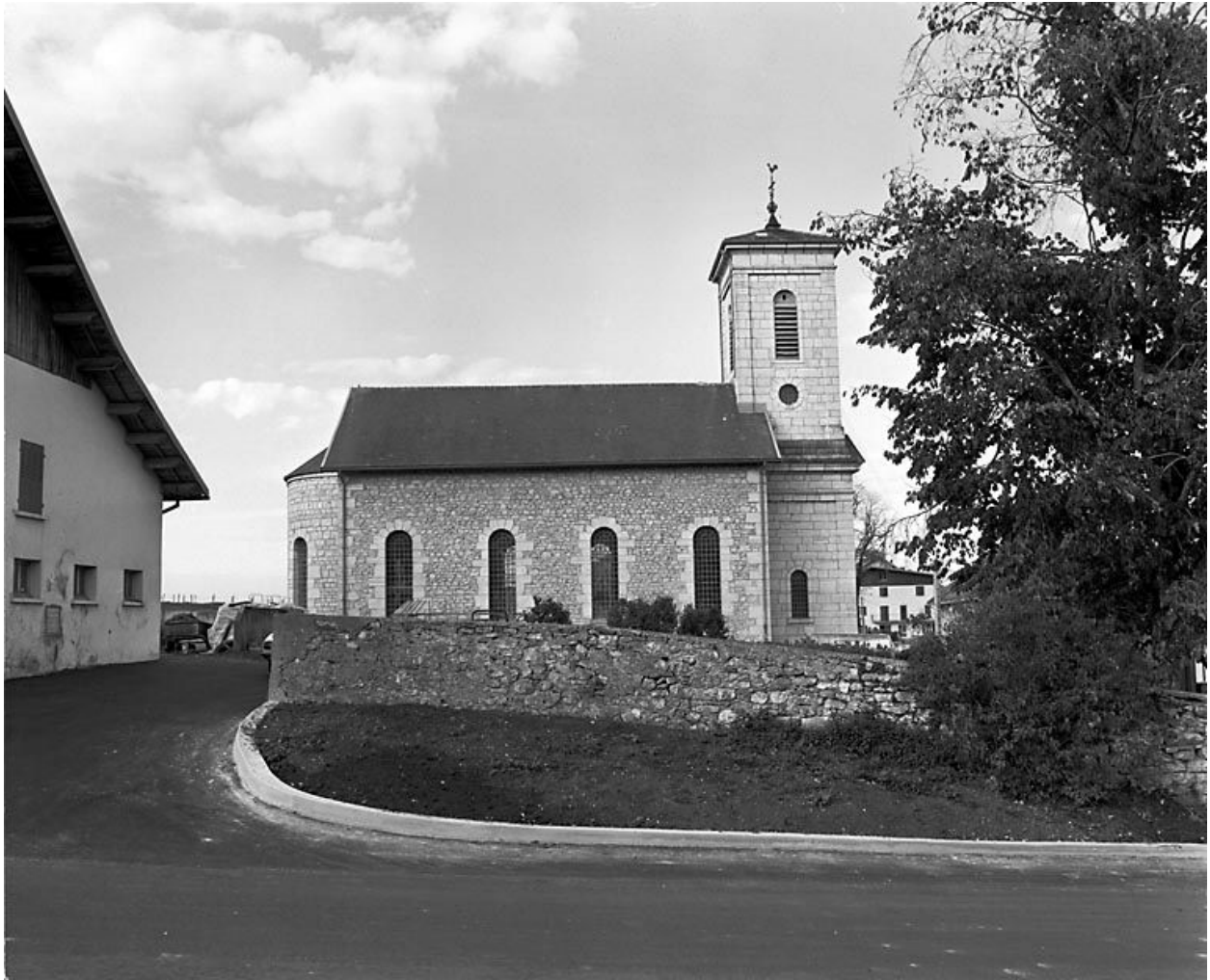
Façade latérale droite.
