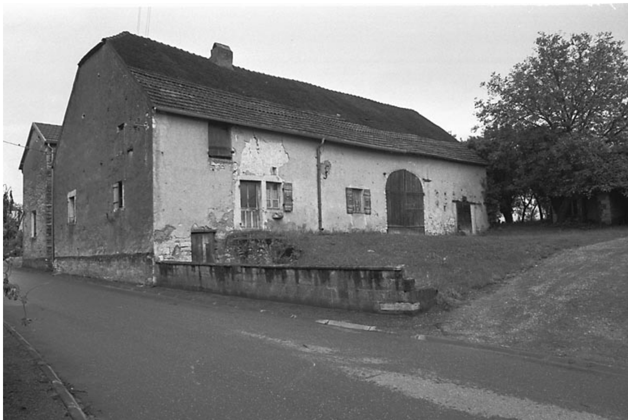
Aubigny, exemple de ferme-bloc à trois travées.
