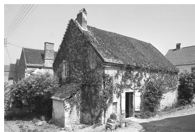
Chaumercenne, maison située au Village. Phot. Bernard Lardière IVR43_19817000313Z
