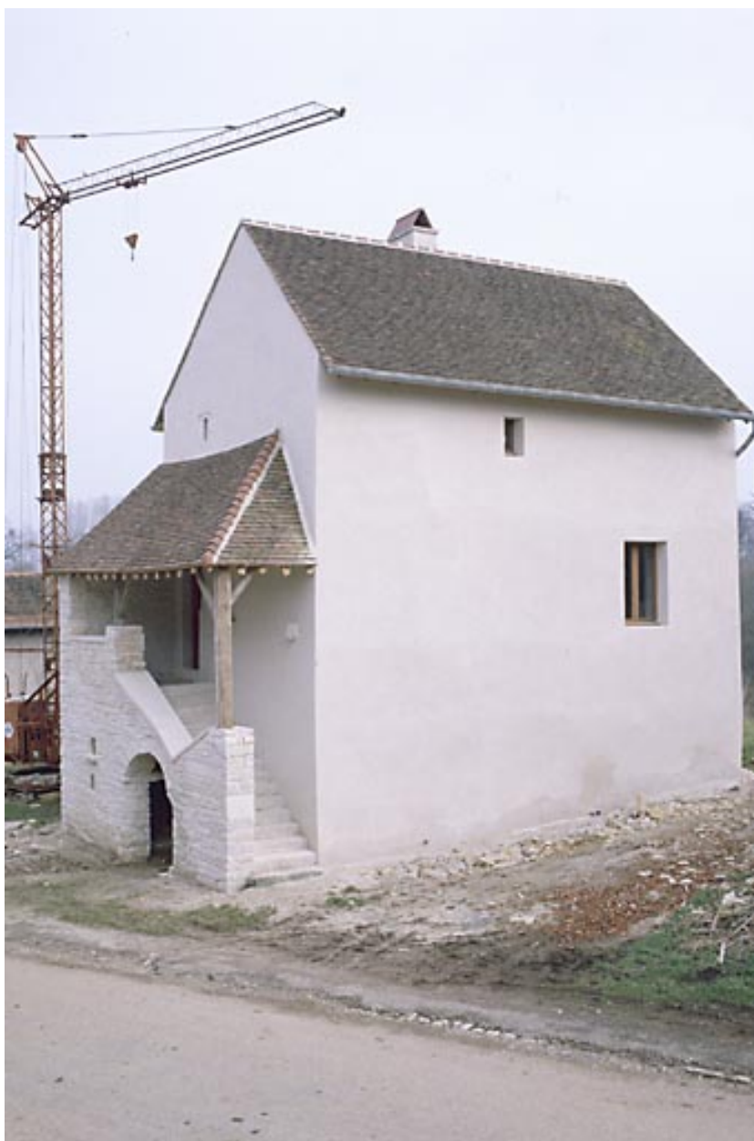
Bard-lès-Pesmes, maison de vigneron située rue Basse.
