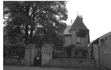
Vadans, maison située rue de Lieucourt.
