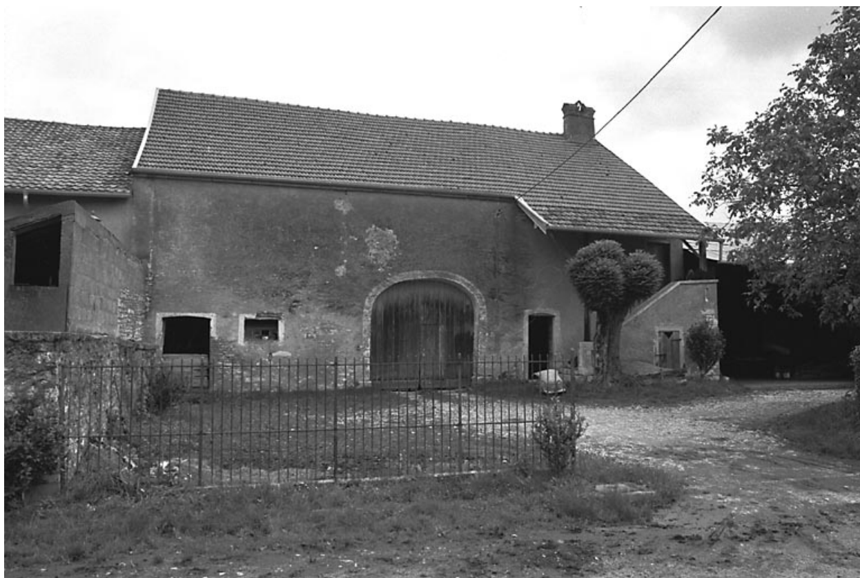
Chevigney, ferme située rue de la Fontaine : exemple de ferme avec escalier extérieur sous auvent.
