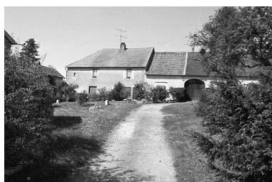
Lieucourt, ferme située rue Champs des Oies. Phot. Bernard Lardière IVR43_19817000423Z
