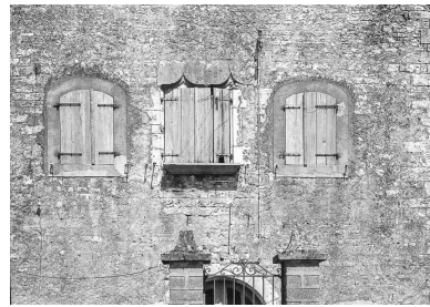
Valay, maison située rue Fénelon : exemple de mur en moellons calcaire recouverts d'enduit. Phot. Bernard Lardière IVR43_19817000141Z
