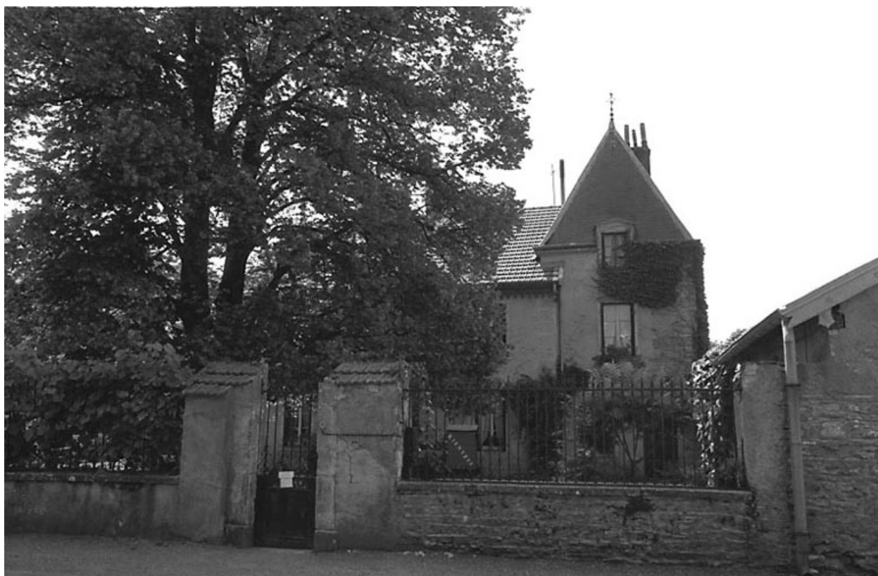
Vadans, maison située rue de Lieucourt.
