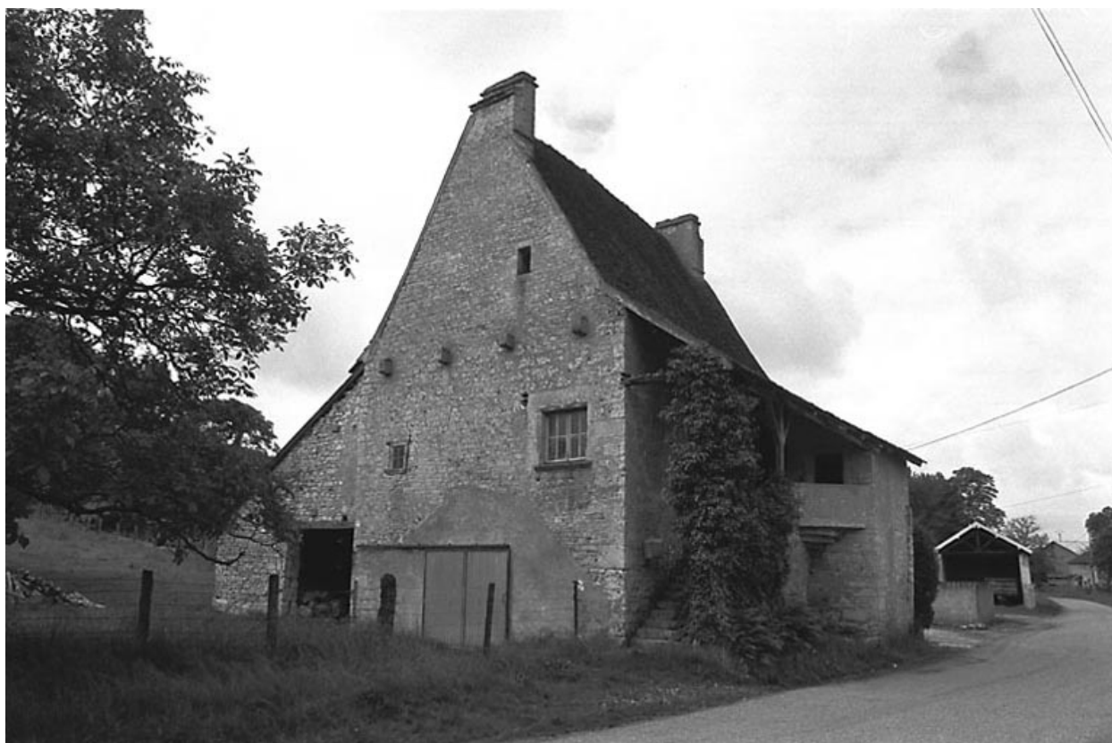
Chevigny, maison située rue de l'Eglise.
