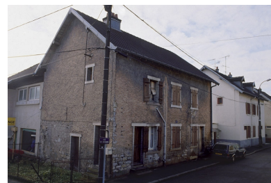
Logement ouvrier situé au n ° 16 de la rue de Bussang. Phot. Jérôme Mongreville IVR43_20019000741ZA
