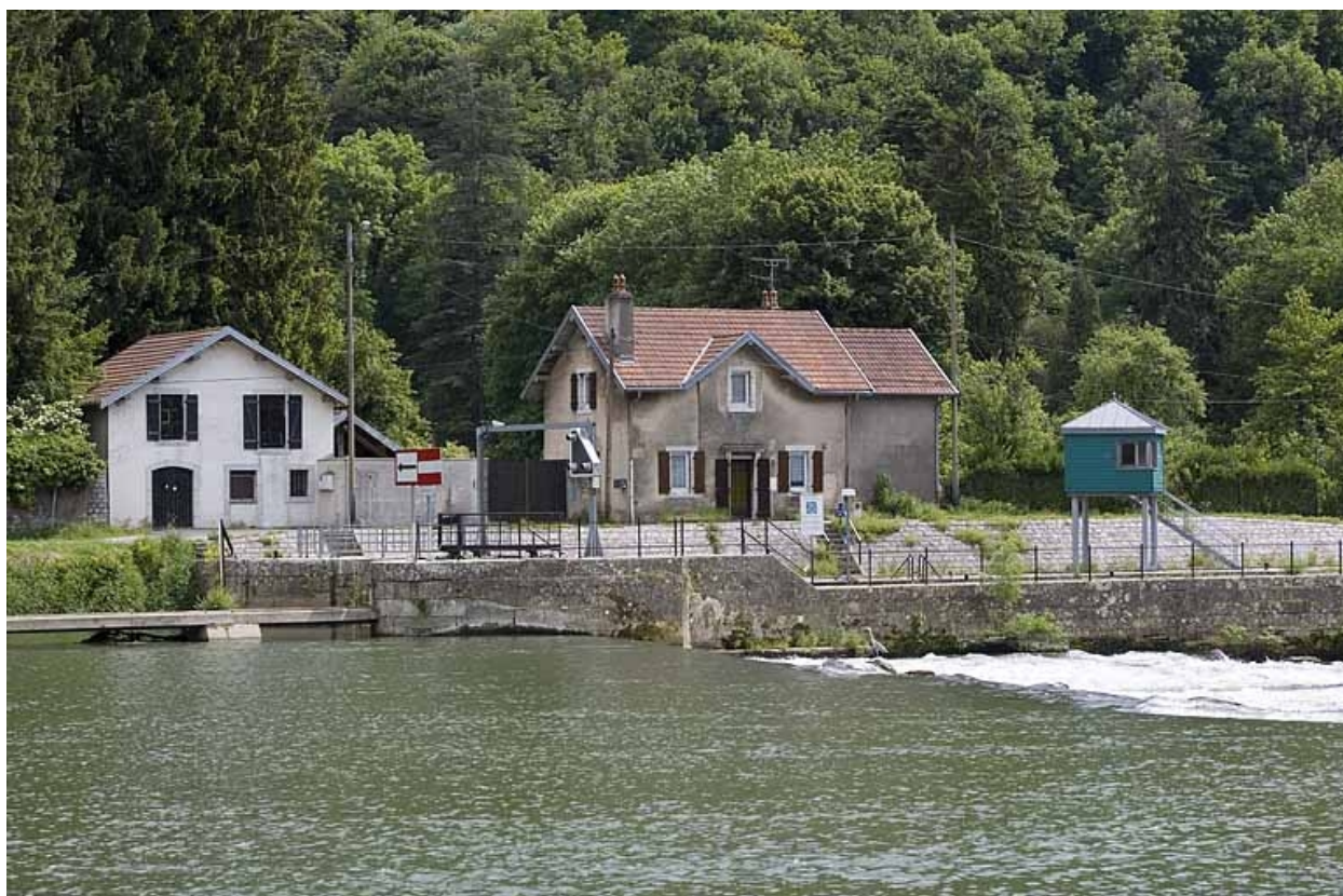
Besançon : site d'écluse n° 52 de Velotte.
