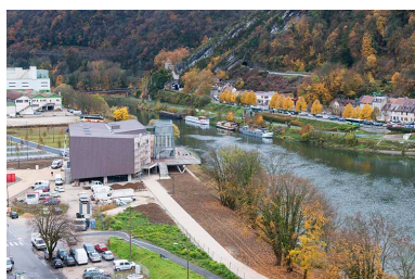
Besançon, port des Près-de-Vaux : vue plongeante sur le site et la salle des musiques actuelles La Rodia. Phot. Jérôme Mongreville IVR43_20102501556NUC4A
