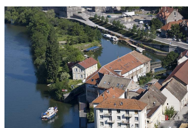
Besançon : écluse n° 51 de Tarragnoz. Phot. Yves Sancey IVR43_20062500204NUCA
