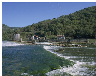
Besançon : site d'écluse n° 49 de la Malate. Phot. Jérôme Mongreville IVR43_20032500210XA
