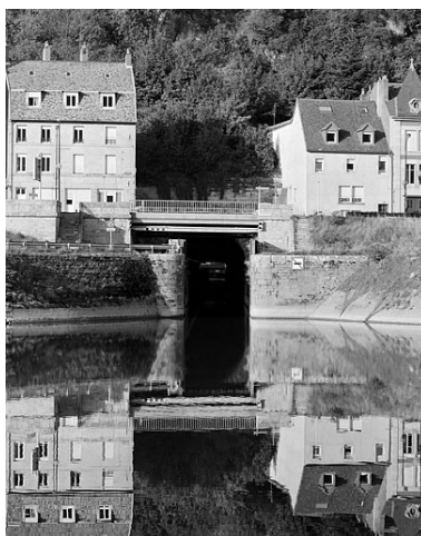
Besançon, tunnel sous la citadelle : porte de garde et extrémité amont. Phot. Jérôme Mongreville IVR43_20032500164X
