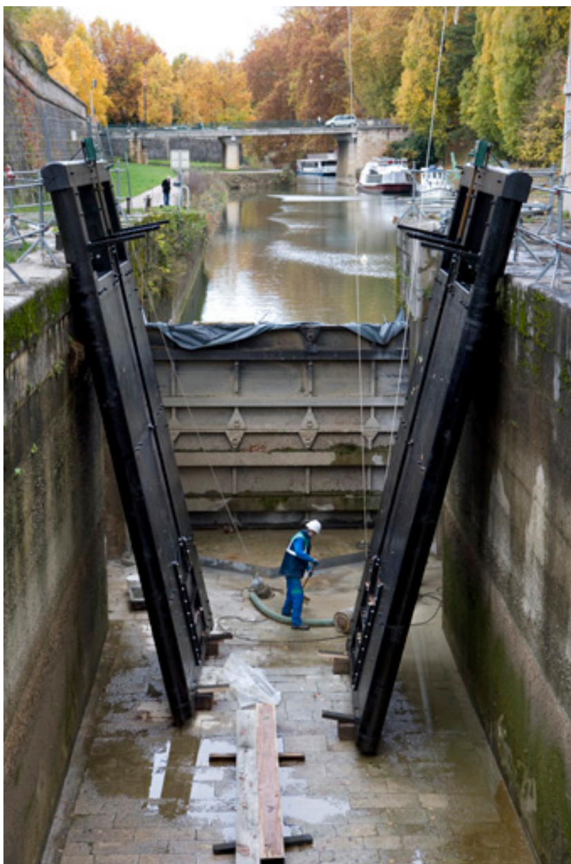
Besançon, écluse n° 50 de Saint-Paul : remise en place des portes, 15 novembre 2009 : nettoyage du radier près de la porte aval.
