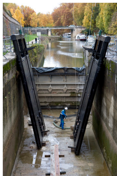
Besançon, écluse n° 50 de Saint- Paul : remise en place des portes, 15 novembre 2009 : nettoyage du radier près de la porte aval. Phot. Yves Sancey IVR43_20092501581NUC2A
