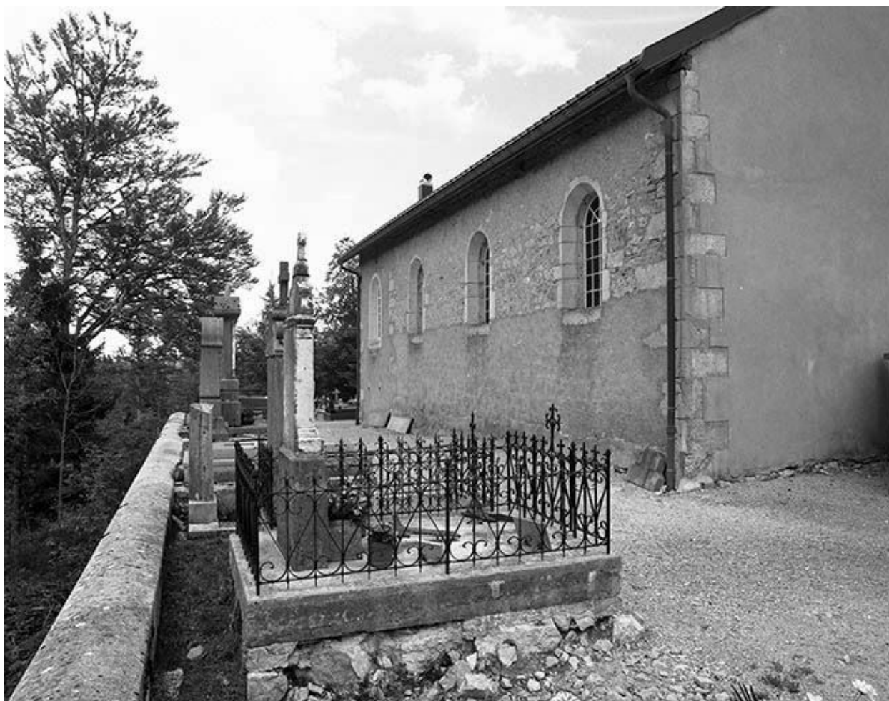
Façade gauche vue de trois quarts.
