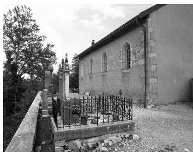
Façade gauche vue de trois quarts. Phot. Jérôme Mongreville IVR43_20003900618X
