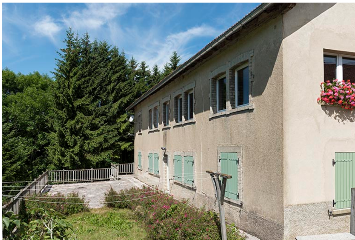
Façade sud, vue en enfilade.
