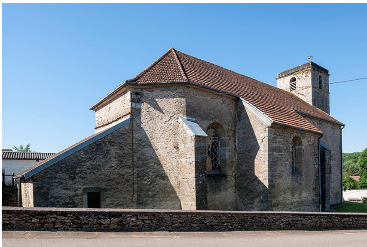
Vue latérale Nord, chevet et sacristie
