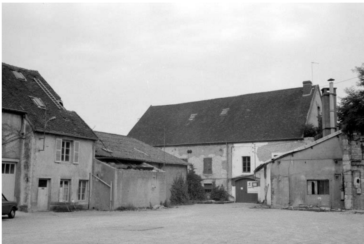
Ateliers de fabrication (H, J) et hangar.
