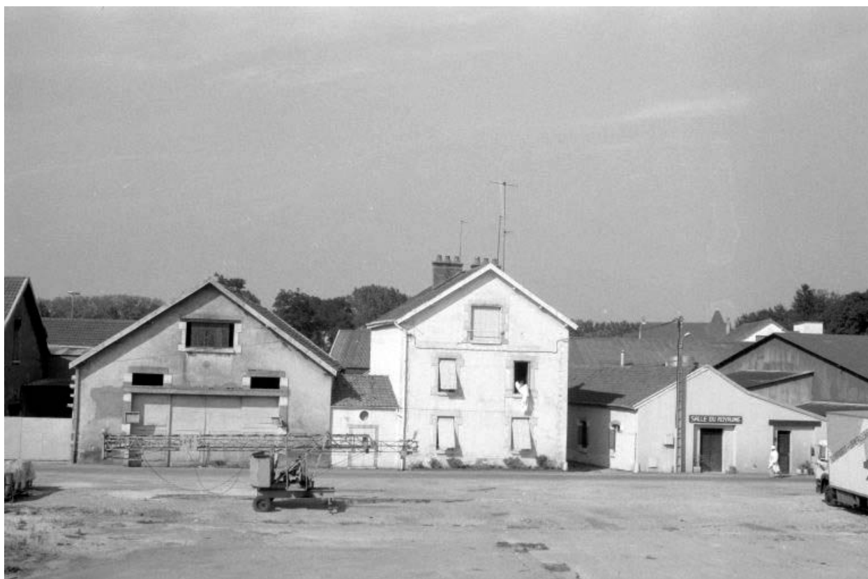
Façade antérieure des écuries et magasins industriels.
