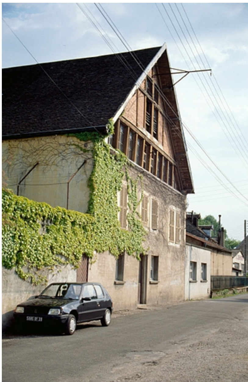
Façade antérieure de l'atelier de fabrication (J).
