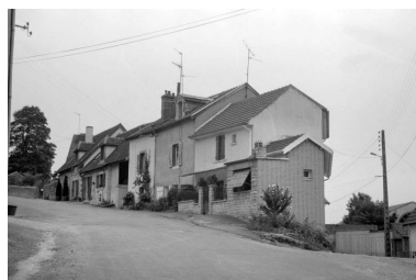
Logements d'ouvriers, depuis le nord. Phot. Laurent Poupard IVR43_19893900117Z
