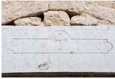
Détail d'un linteau de la façade sud. Phot. Jérôme Mongreville IVR43_20142501092NUC4A
