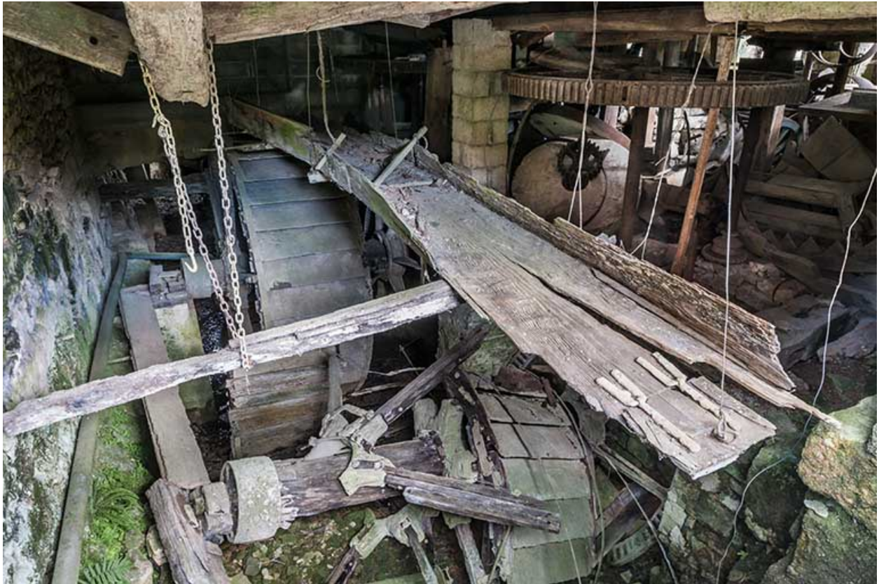
Vue plongeante sur la partie motrice : vestiges de deux roues hydrauliques et de la huche d'amenée.
