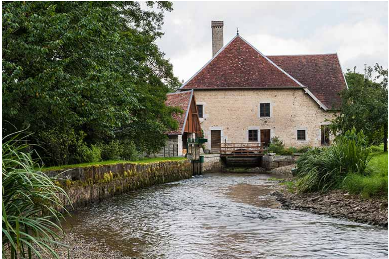
Vue depuis l'amont (canal d'amenée vidé).
