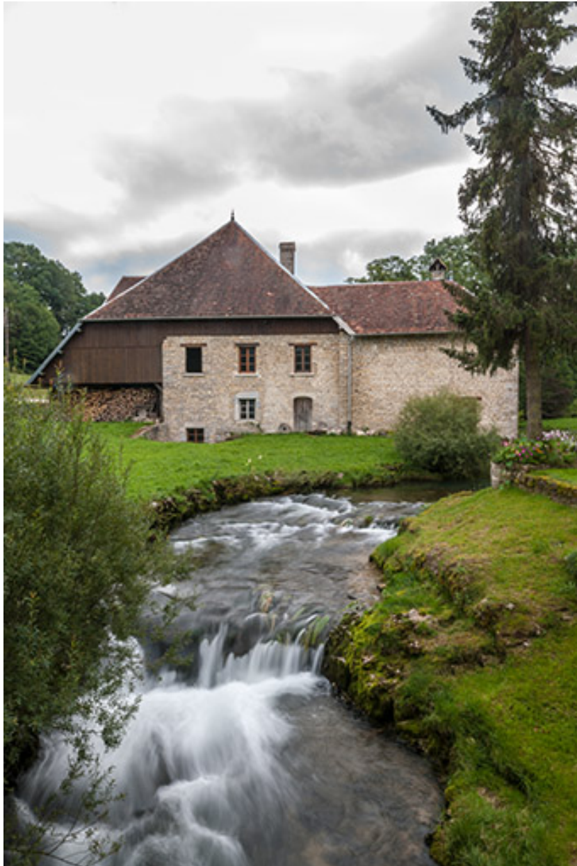
Vue d'ensemble depuis le nord-ouest (cadrage vertical).
