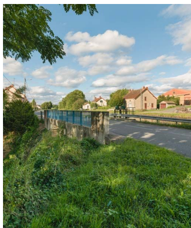
Vue du déversoir.
