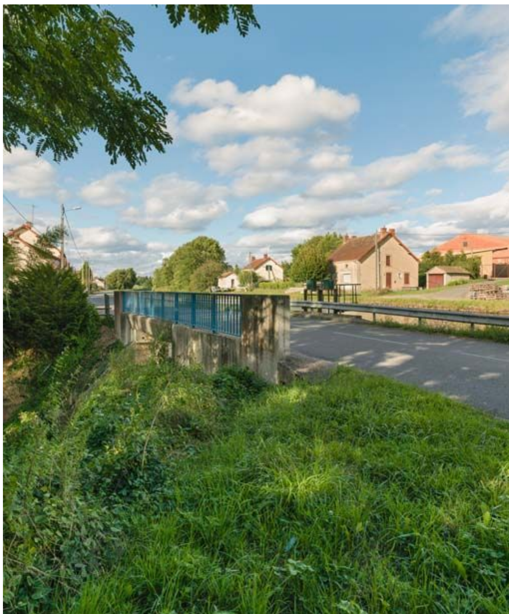
Vue du déversoir.
