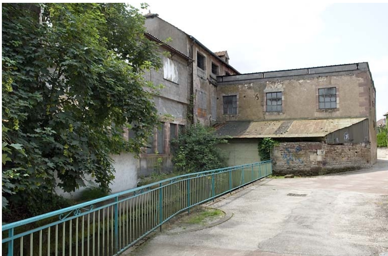
Façades postérieures donnant sur le bief.
