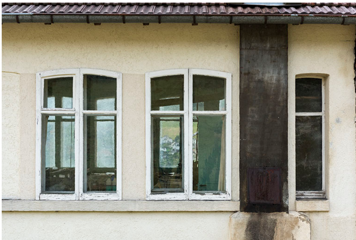
Atelier de fabrication : fenêtre horlogère au nord.
