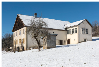
Façade latérale droite et atelier de fabrication, en hiver. Phot. Sonia Dourlot IVR43_20192500482NUC4A
