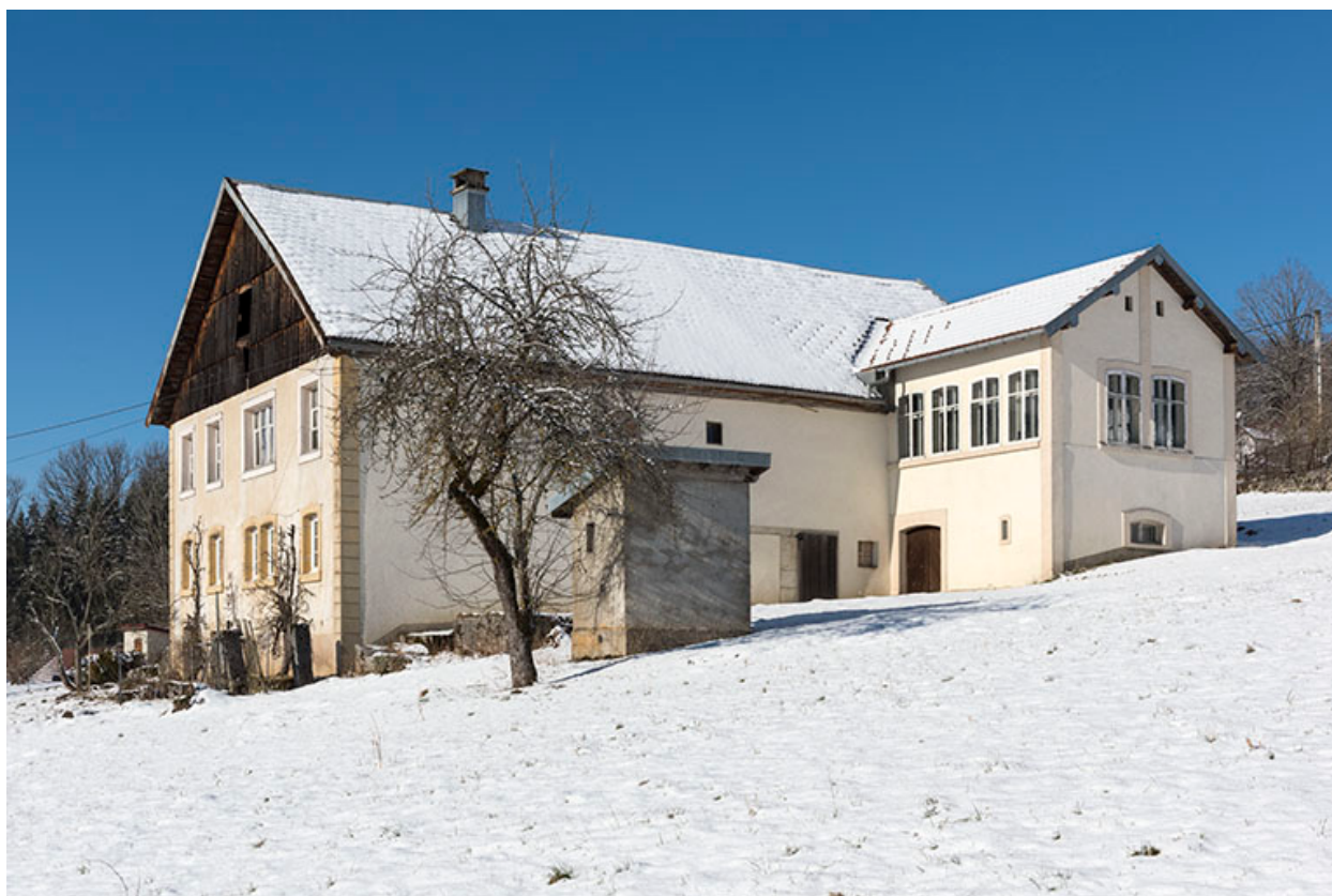
Façade latérale droite et atelier de fabrication, en hiver.
