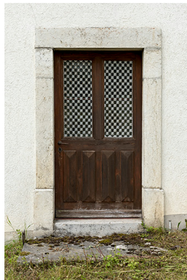
Façade latérale droite : porte. Phot. Sonia Dourlot IVR43_20162500859NUC4A
