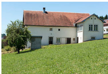
Façade latérale droite et atelier de fabrication. Phot. Sonia Dourlot IVR43_20162500856NUC4A
