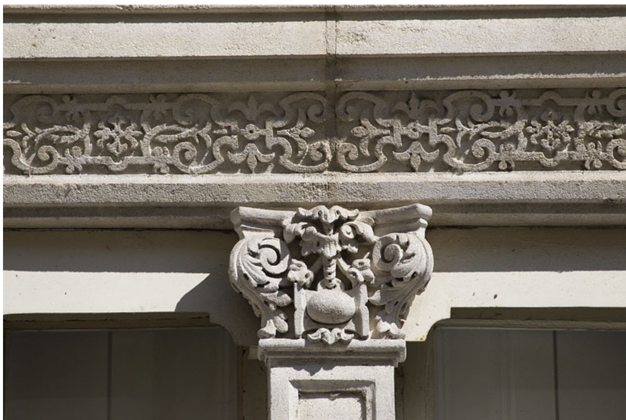
Façade antérieure, fenêtre du premier étage : détail d'un chapiteau composé couonnant le meneau.
