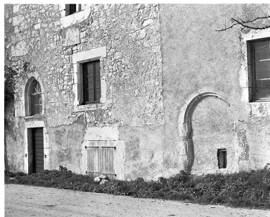
Façade sur rue, partie centrale. Phot. Dominique Dominguez IVR43_19792501019X
