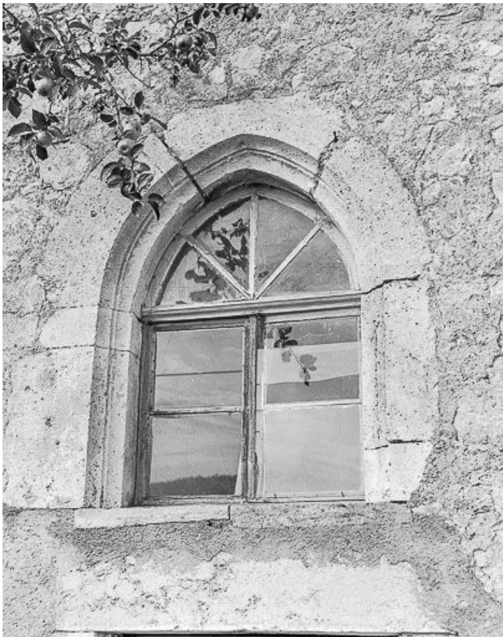
Détail de la façade sur rue : fenêtre.
