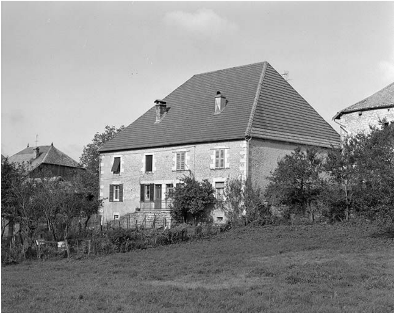
Façade postérieure et face latérale gauche.
