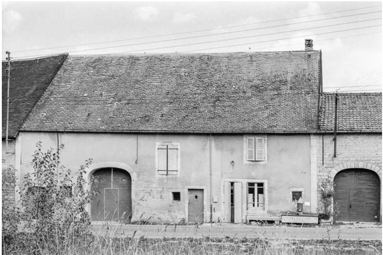
Façade antérieure : vue rapprochée.
