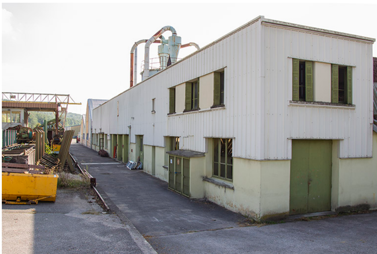
Atelier construction : façade antérieure.
