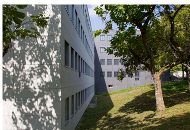
Internat : façades rinnovées. Phot. Sonia Dourlot IVR43_20143900676NUC2A
