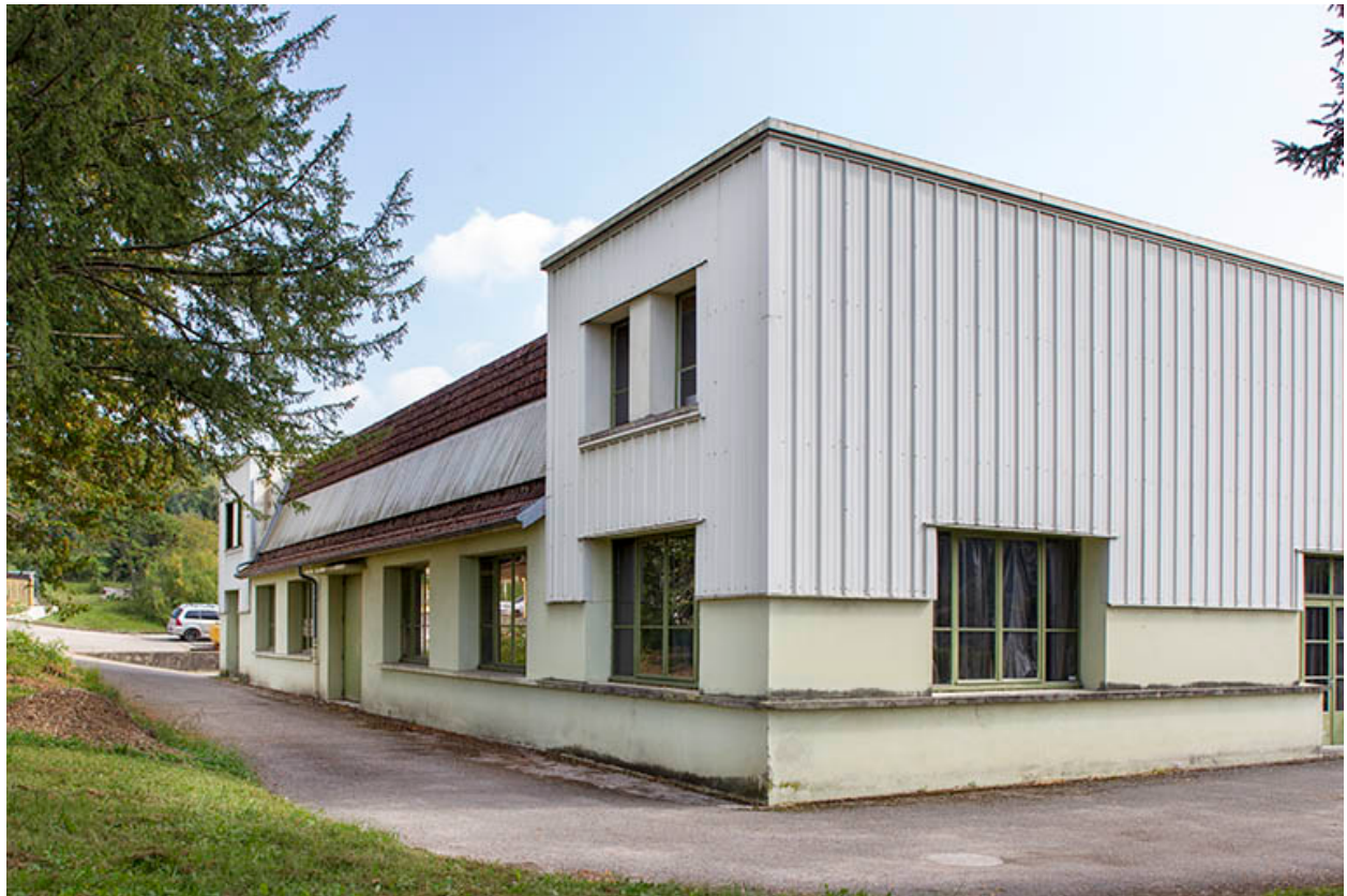
Atelier construction : façade postérieure.
