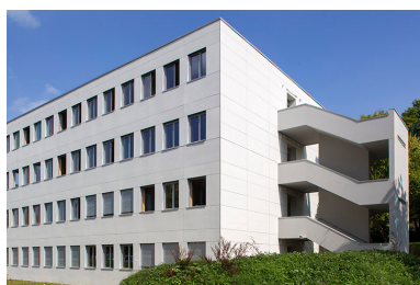
Internat : détail des parements de façade. Phot. Sonia Dourlot IVR43_20143900675NUC2A
