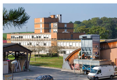
Externat : vue générale. Phot. Sonia Dourlot IVR43_20143900653NUC2A
