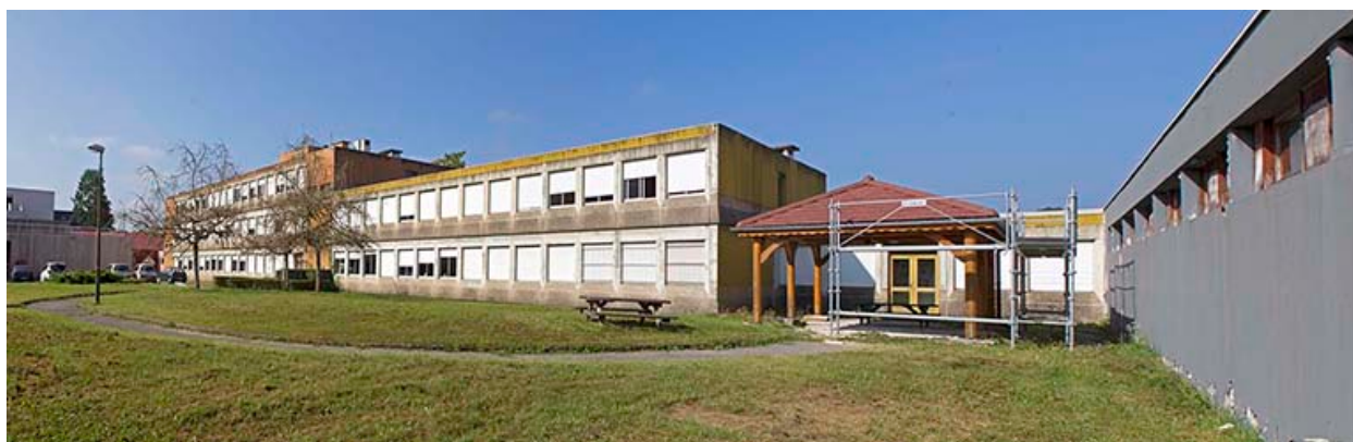
Externat : façade postérieure.
