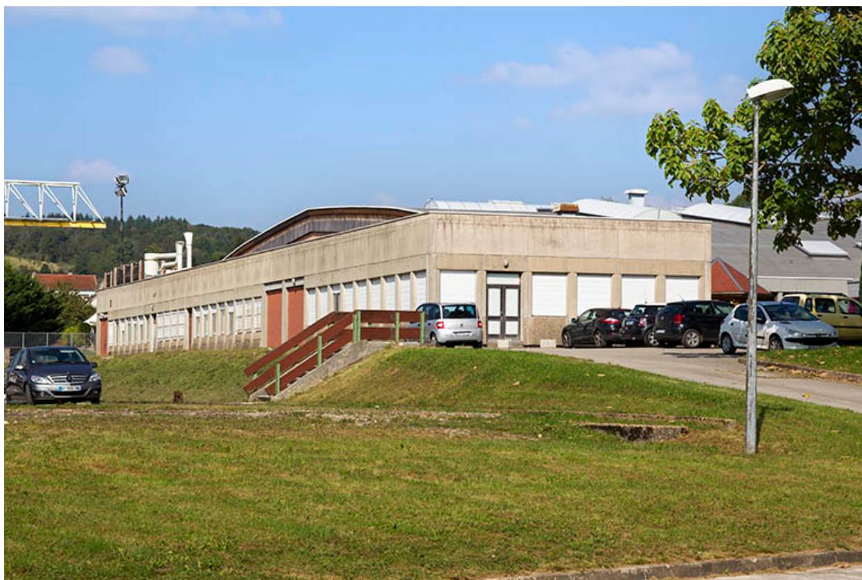
Atelier : salles de cours.
