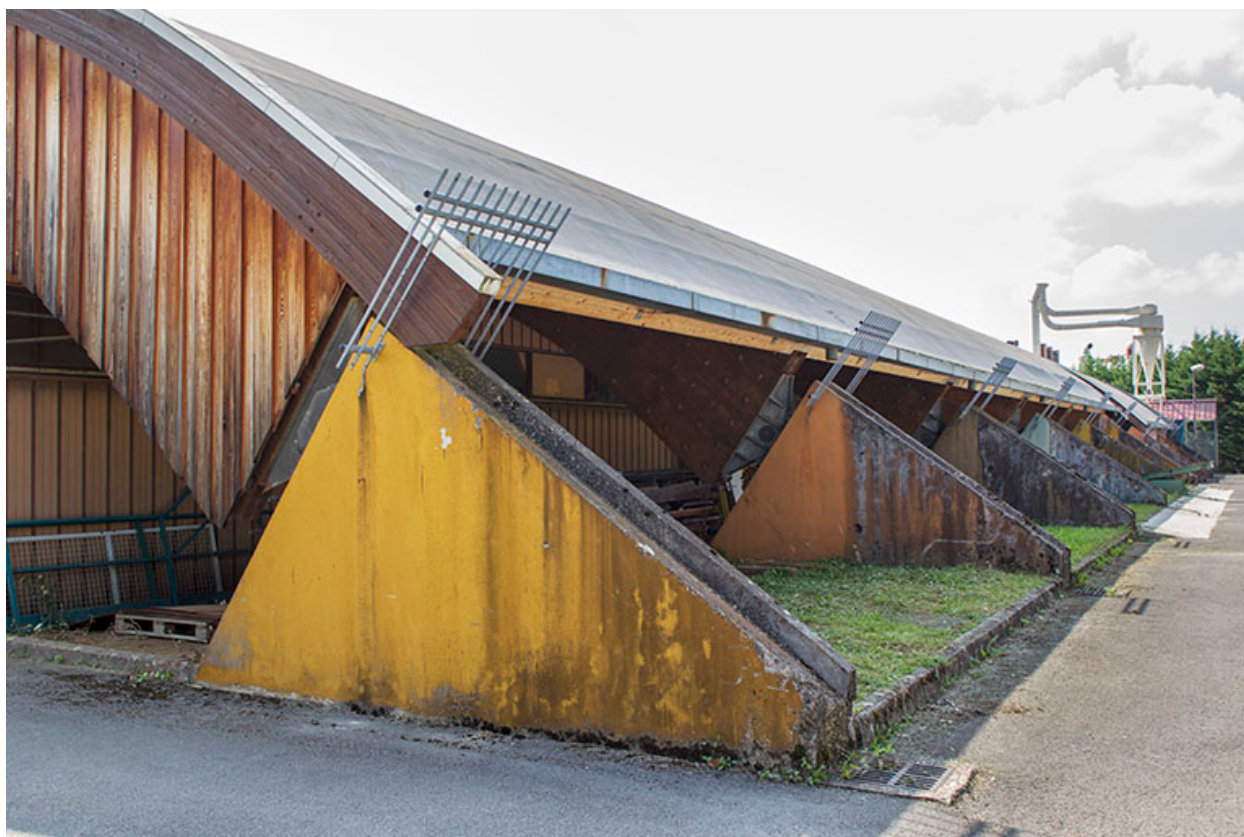
Atelier : couverture avec charpente, détail.
