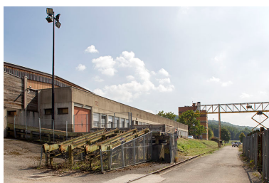
Atelier : façade ouest. Phot. Sonia Dourlot IVR43_20143900638NUC2A
