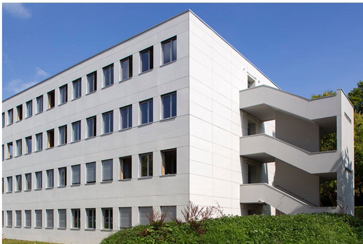
Internat : détail des parements de façade.
