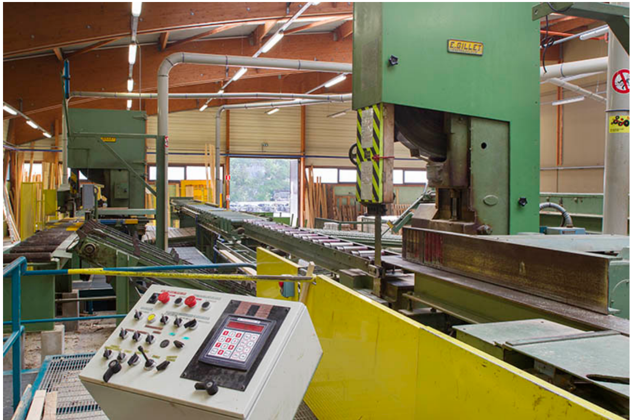
Scierie : poste de commande automatisé.
