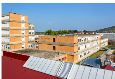
Externer et amination : façades et toitures. Phot. Sonia Dourlot IVR43_20143900656NUC2A
