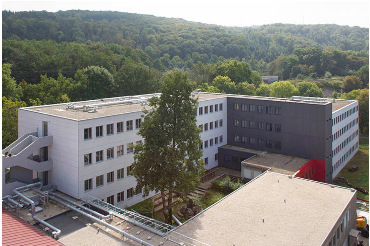
Internat : vue générale après restauration des façades.
