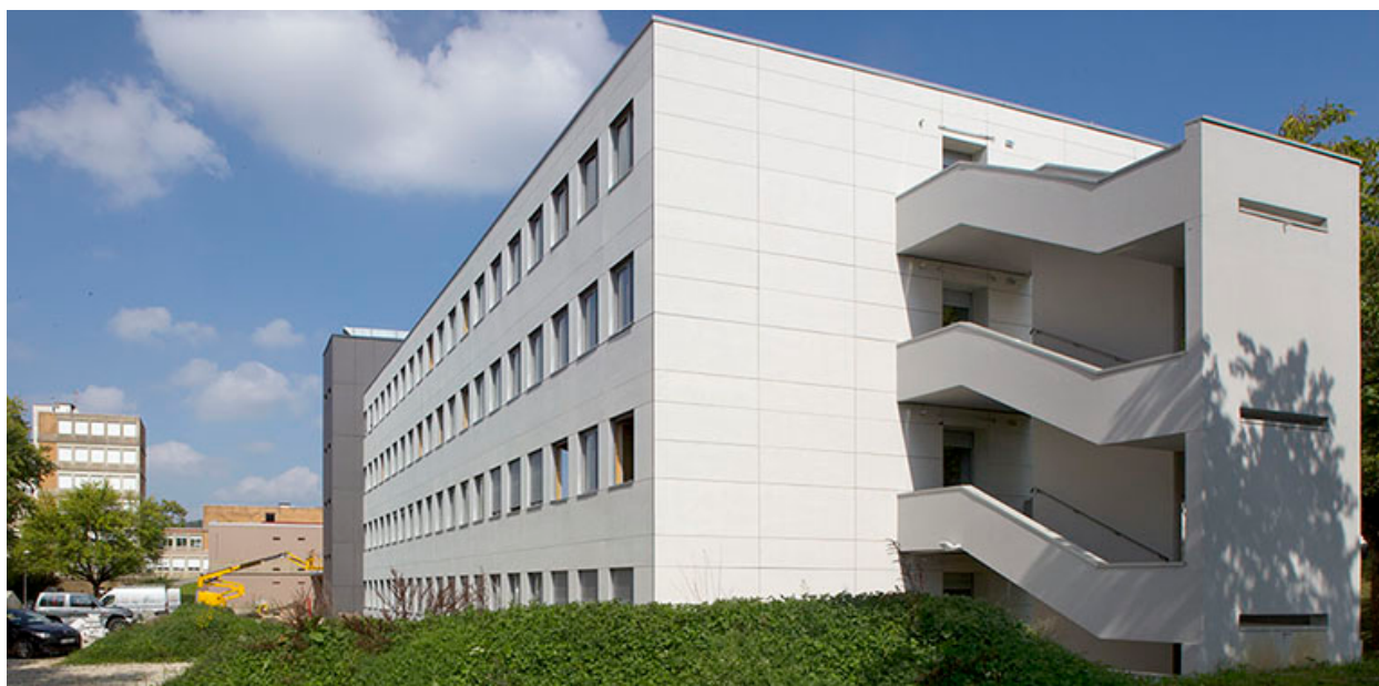
Internat : façade sud.
