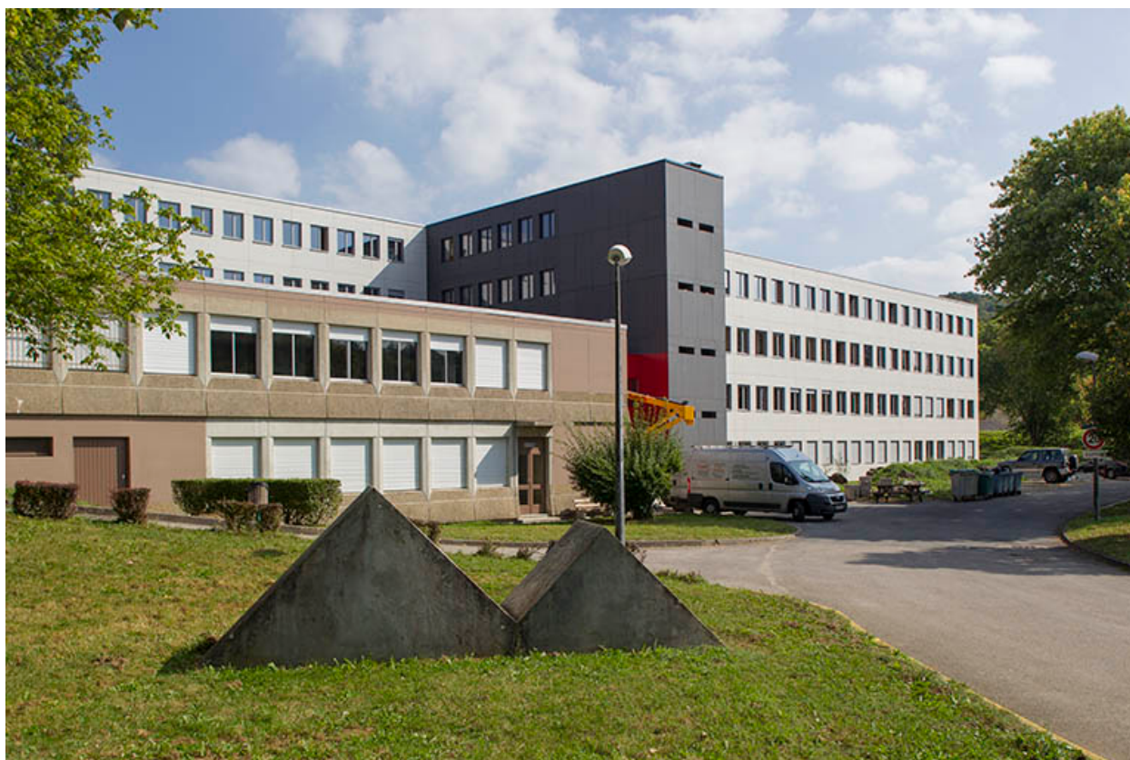
Internat : façade ouest.
