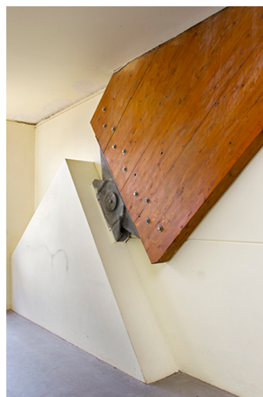
Atelier : charpente, détail. Phot. Jérôme Mongreville IVR43_20143900642NUC2A
