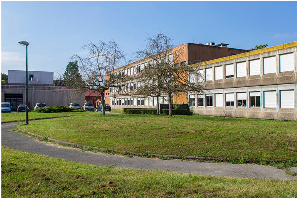
Internat : façade postérieure.
