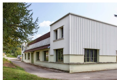
Atelier construction : façade postérieure. Phot. Sonia Dourlot IVR43_20143900621NUC2A
