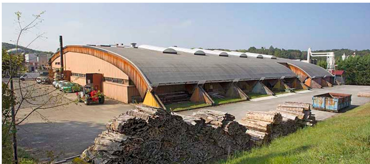
Atelier : couverture avec charpente.
