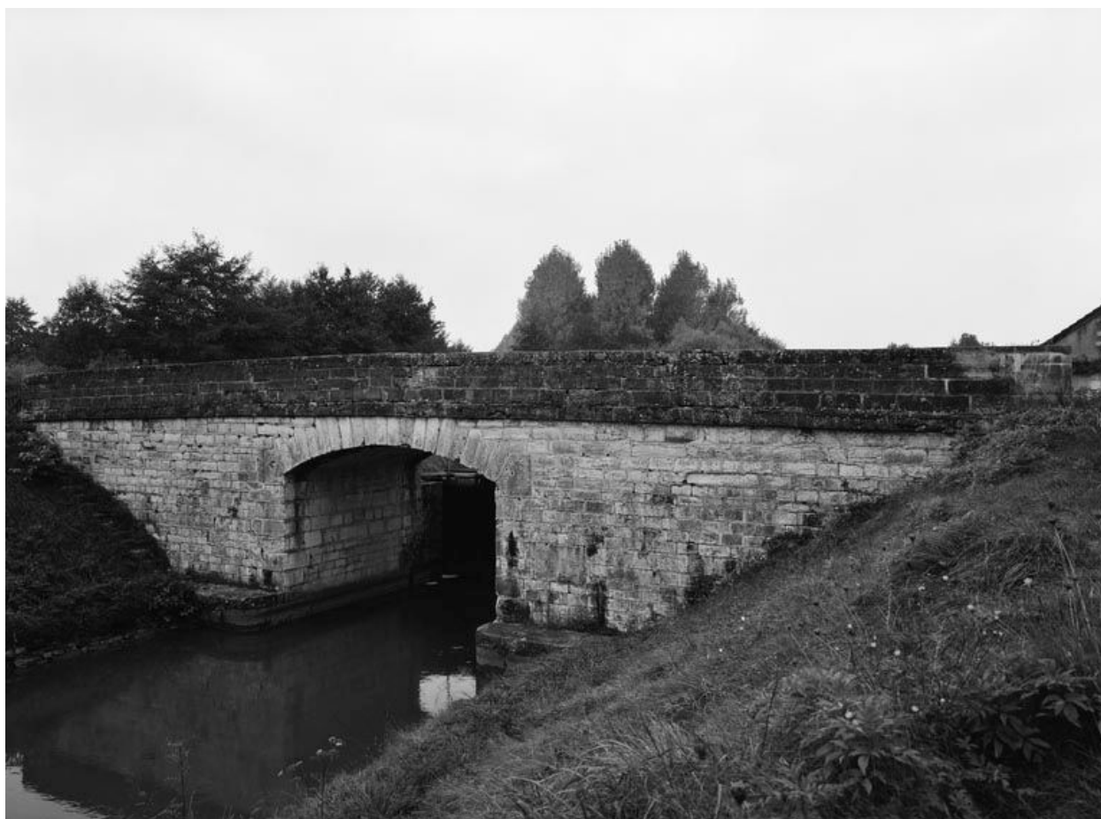
Pont sur écluse.
