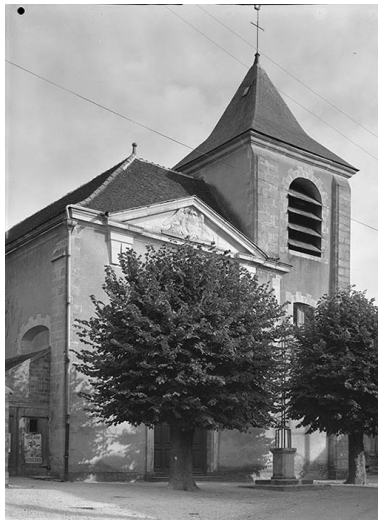
Façade occidentale avec clocher. Phot. Michel Thierry IVR26_19748900681V
