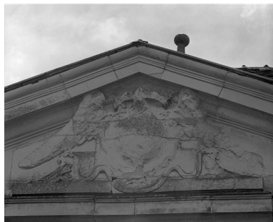
Façade antérieure. Fronton. Phot. Michel Thierry IVR26_19748900684X
