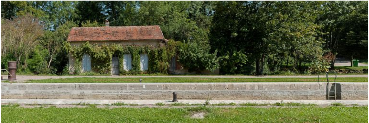
Vue de face de la maison éclusière.
