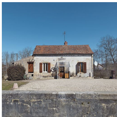
La maison éclusière de face. Phot. Thierry Kuntz IVR26_20122102628NUC4A
