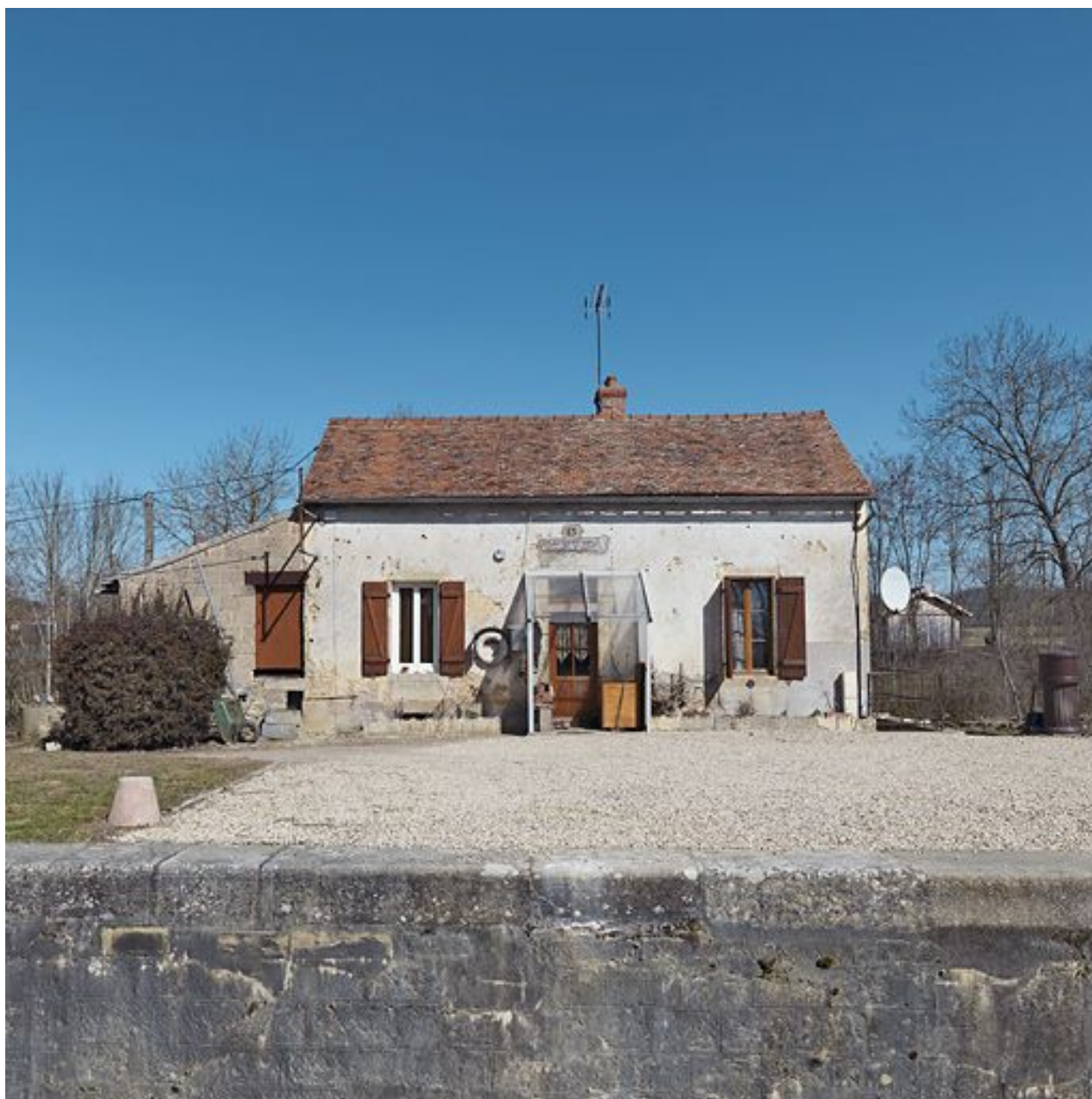
La maison éclusière de face.
