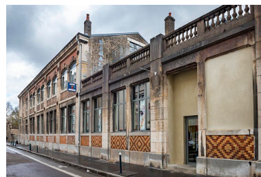
Vue rapprochée depuis le sud-ouest (après travaux). Phot. Jérôme Mongreville IVR43_20192500133NUC4A
