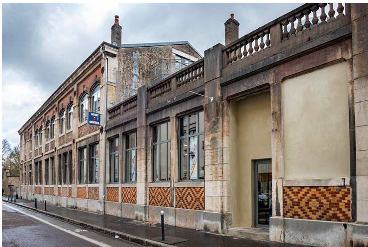
Vue rapprochée depuis le sud-ouest (après travaux).
