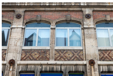
Détail d'une travée. Phot. Jérôme Mongreville IVR43_20172501344NUC4A
