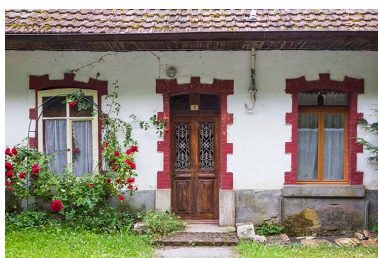
Logements d'ouvriers : façade antérieure du logement nord.
