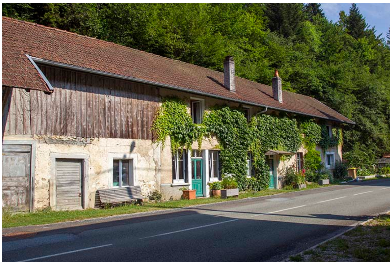
Logements d'ouvriers et écuries.
