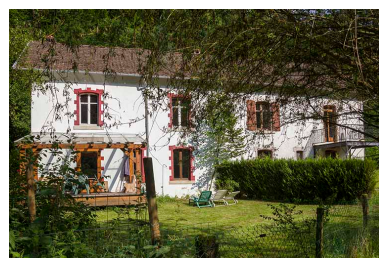
Logements d'ouvriers : façade postérieure.
