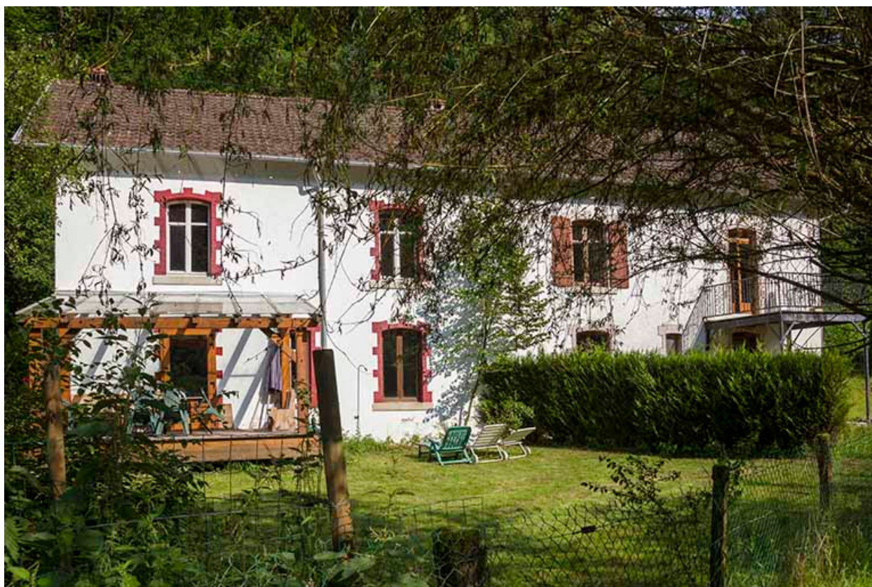
Logements d'ouvriers : façade postérieure.
