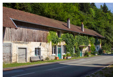
Logements d'ouvriers et écuries.
