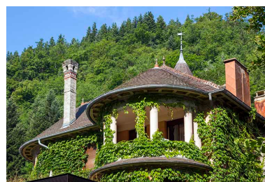
Logement patronal de 1931, façade postérieure : loggia.
