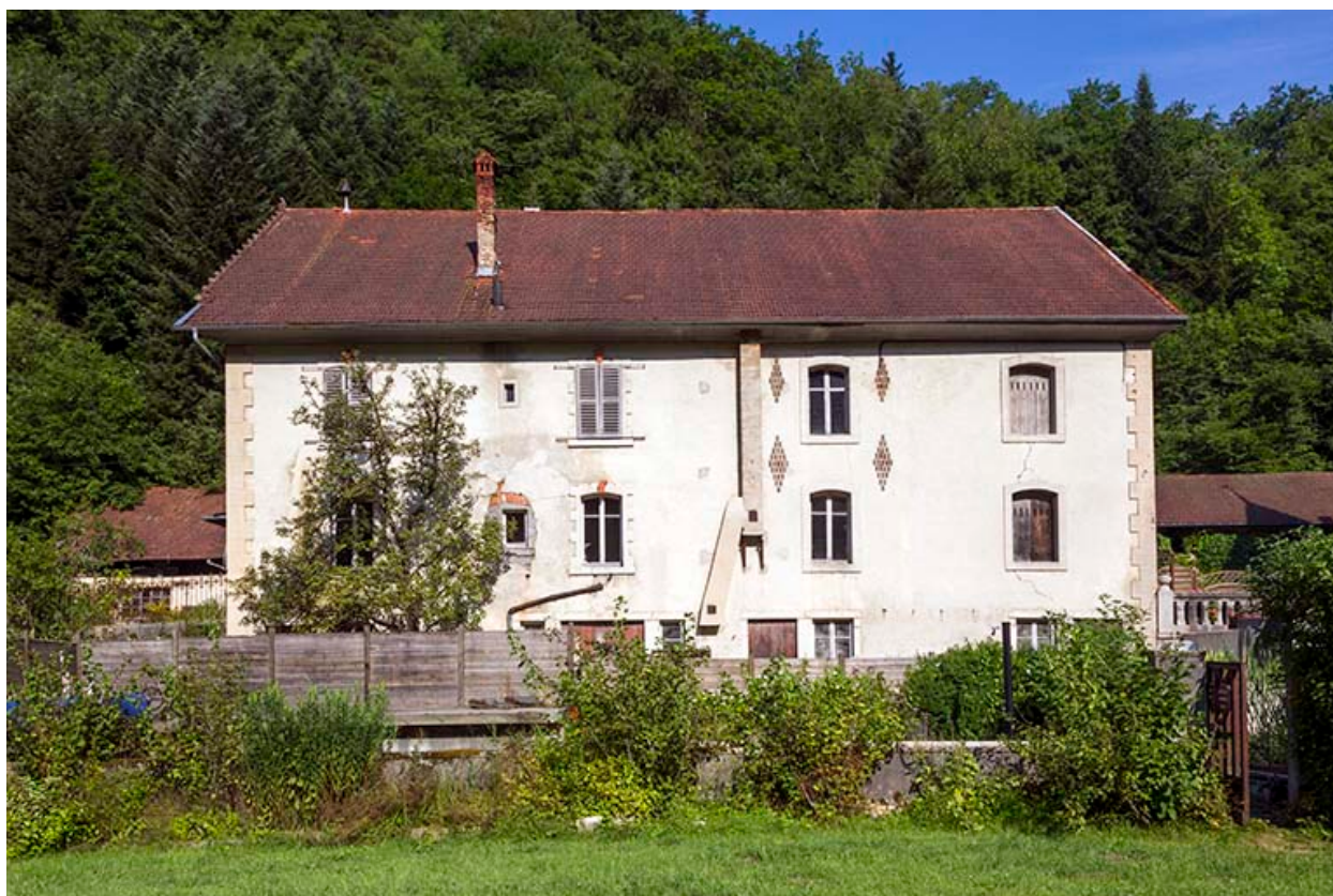
Logement patronal de 1900 : façade postérieure.
