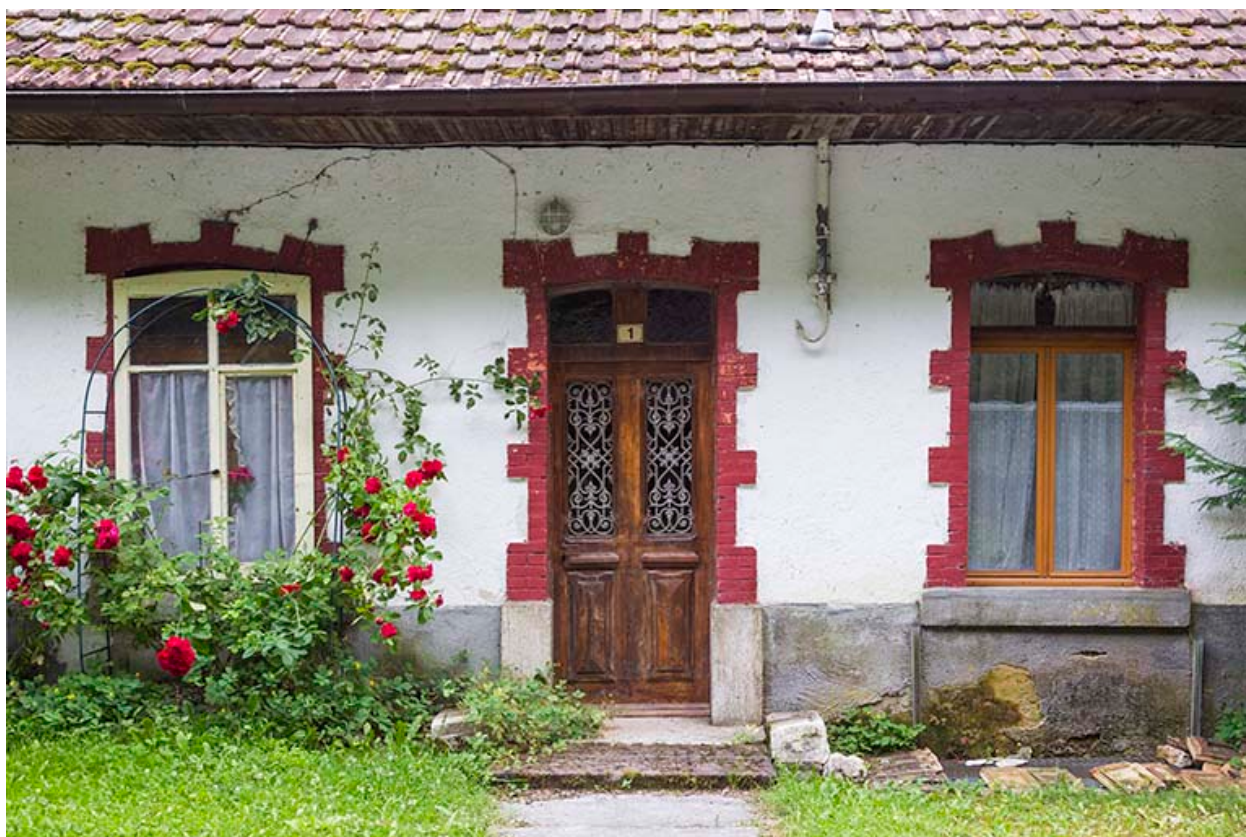
Logements d'ouvriers : façade antérieure du logement nord.
