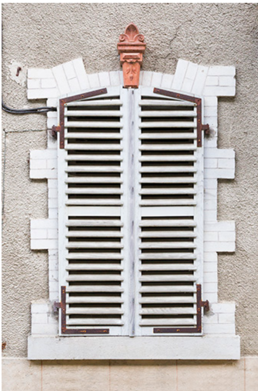
Logement patronal de 1900, façade antérieure : une fenêtre.
