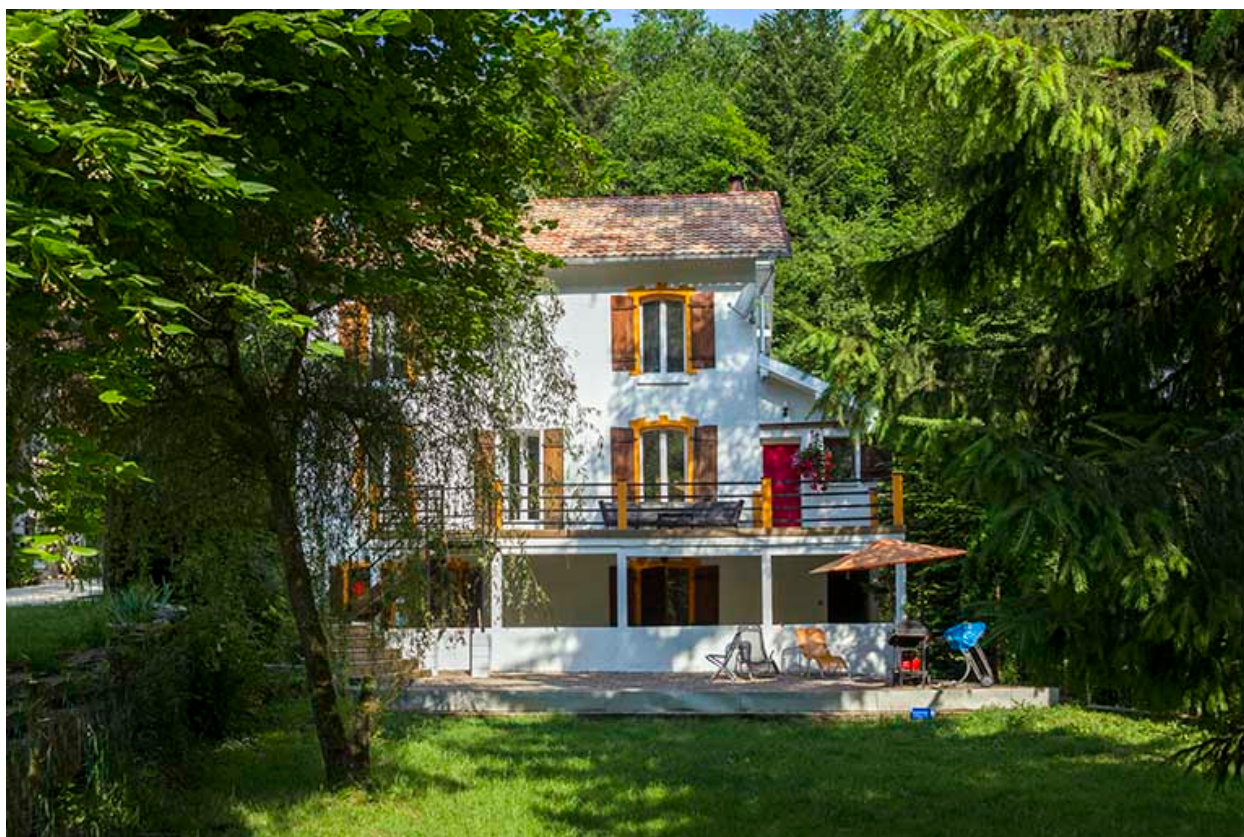
Logement de contremaître : façade postérieure.
