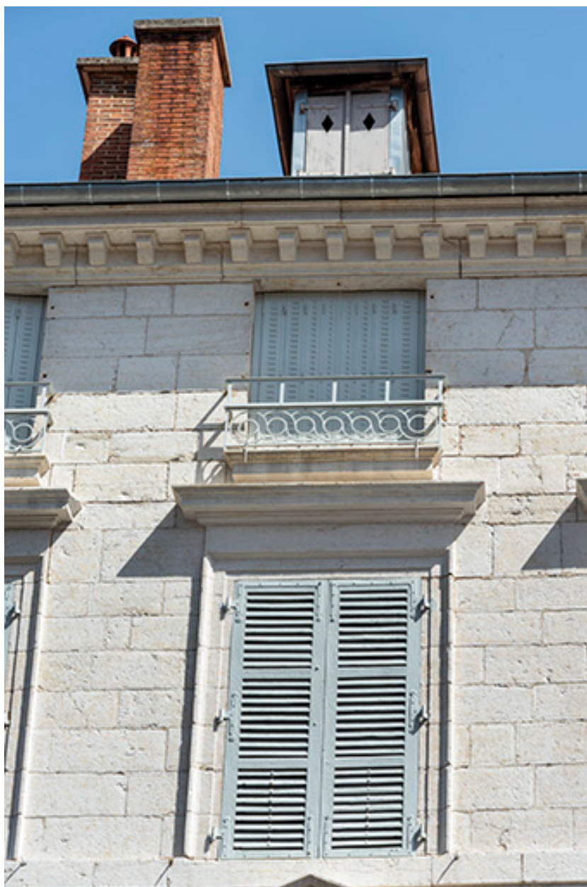
Façade antérieure. Fenêtres des étages supérieurs.
