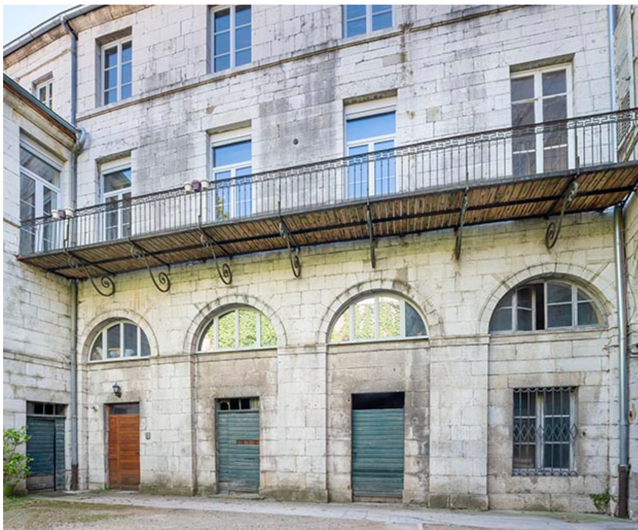
Façade de l'aile sud, depuis la cour.
