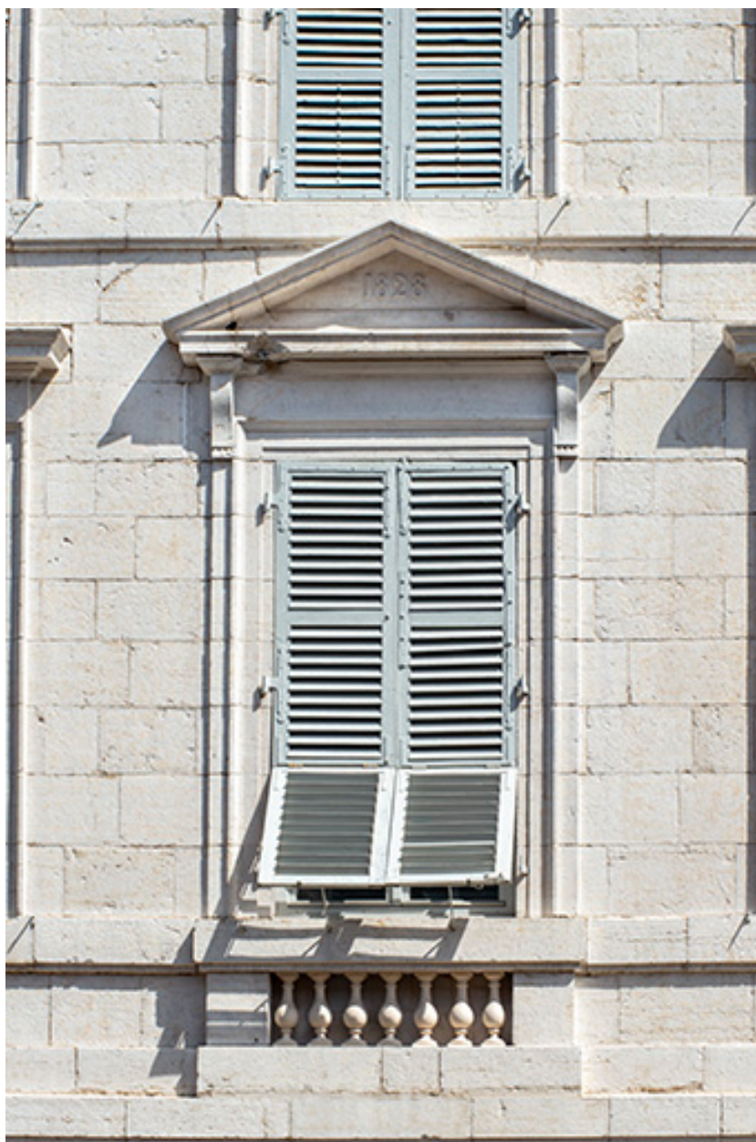
Fenêtre centrale du premier étage.
