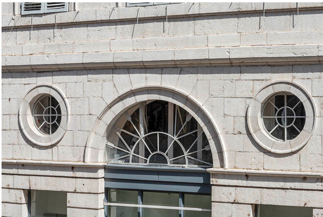
Façade antérieure. Ouvertures de l'entresol.
