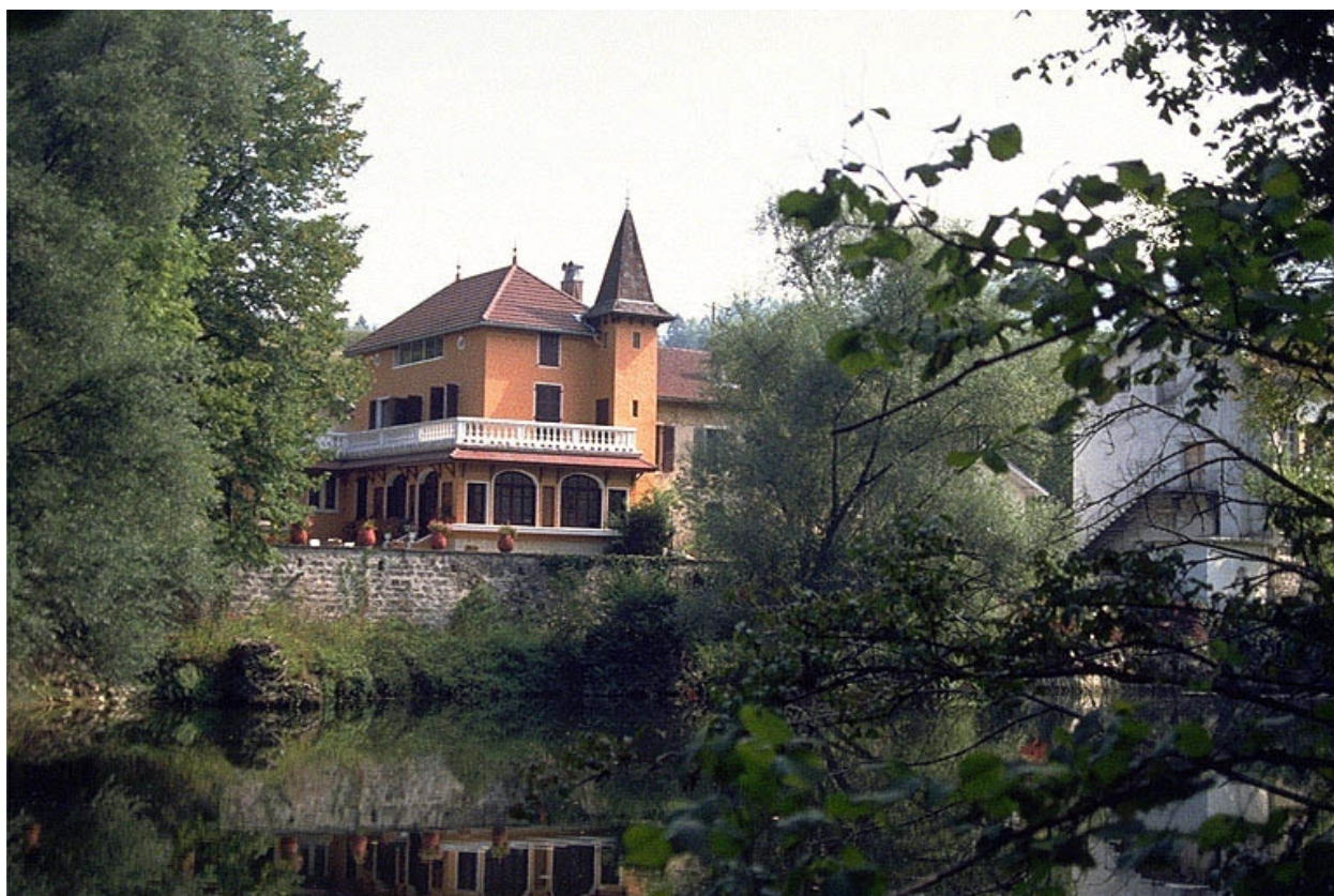
Logement patronal, depuis l'ouest.
