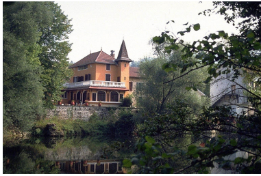
Logement patronal, depuis l'ouest. Phot. Laurent Poupard IVR43_19903900498ZA
