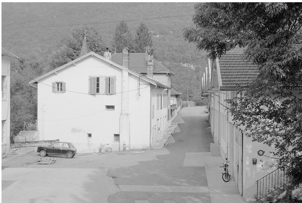
Bureau désaffecté et logement de contremaître.
