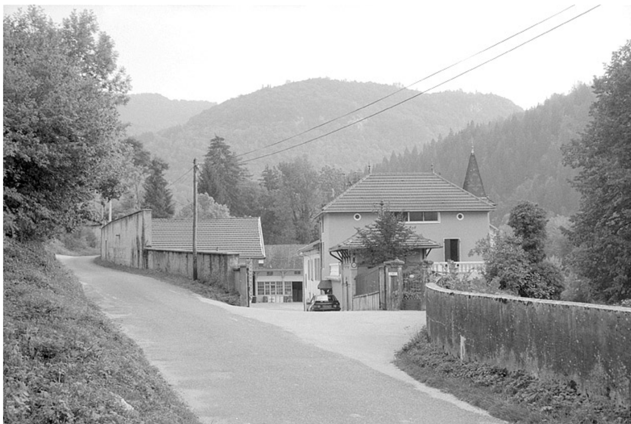
Entrée de l'usine et logement patronal.
