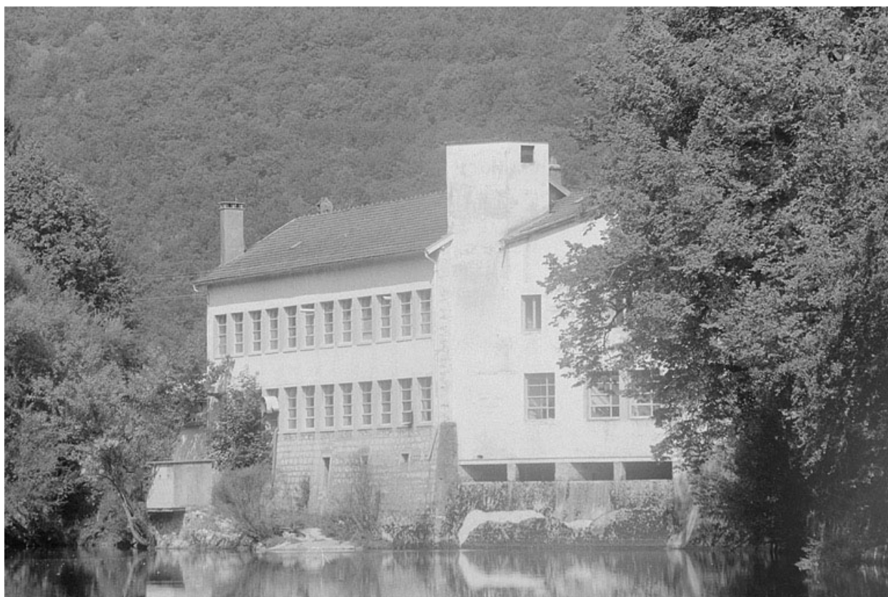
Atelier de fabrication, depuis le sud-est (amont).
