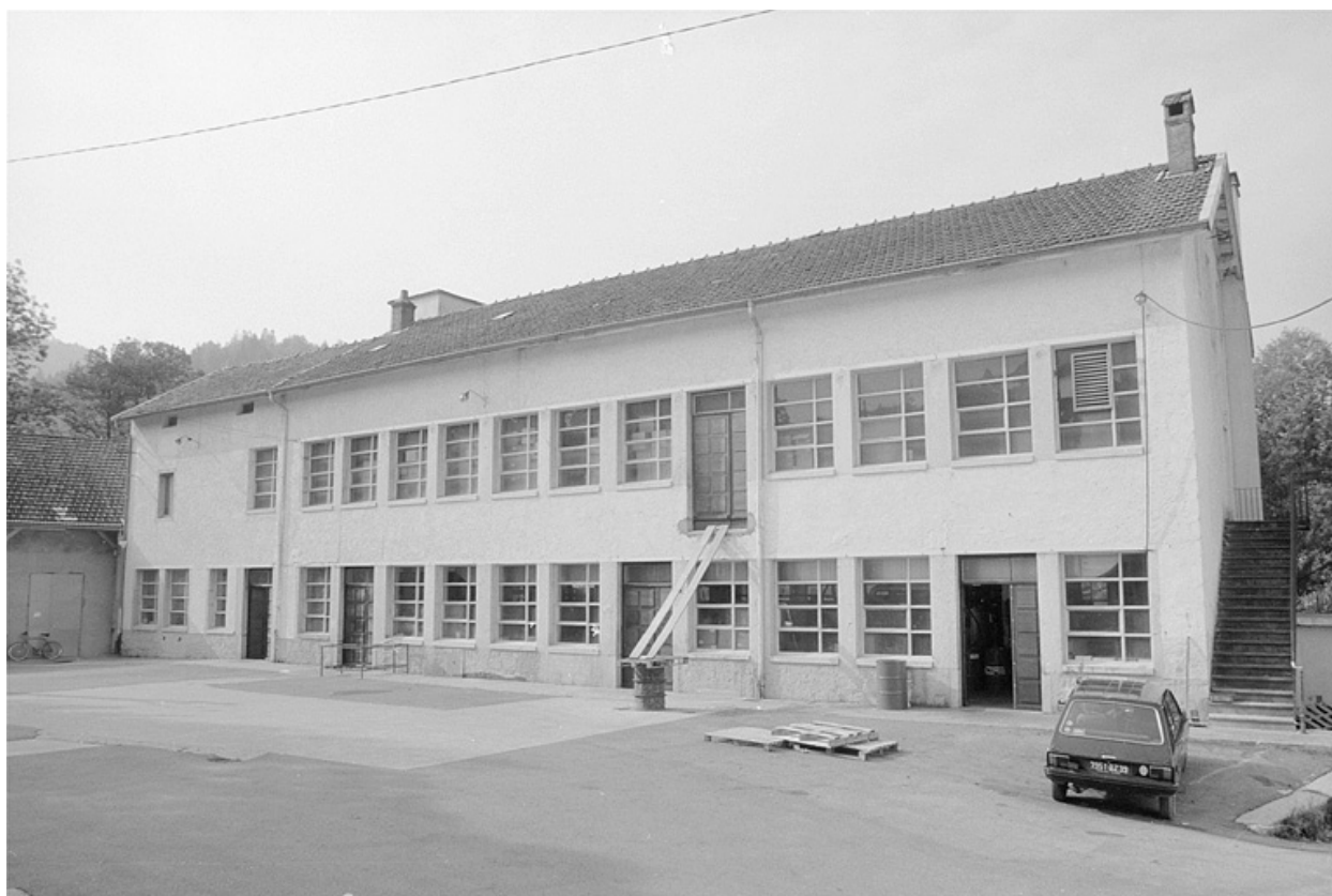
Atelier de fabrication, depuis la cour.
