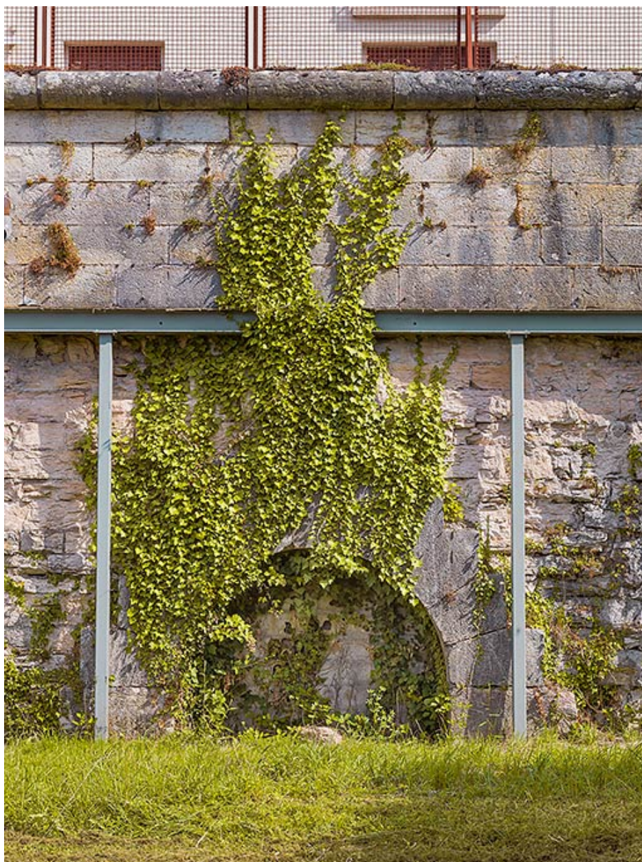
Le mur d'escarpe étayé (détail).
