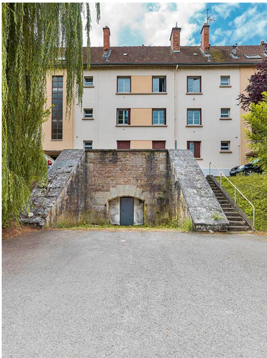
La poterne, vue générale.
