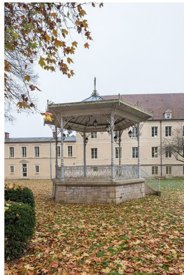
Elévation latérale gauche. Phot. Pierre-Marie Barbe-Richaud IVR26_20212100352NUC4A
