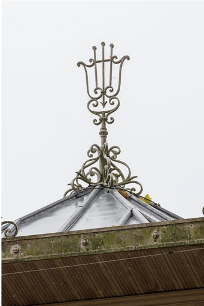
Epi de faitage en forme de lyre.
