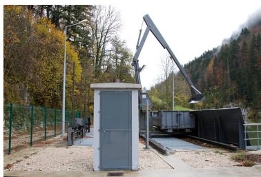
Prise d'eau : dégrilleur automatique et édicule protégeant un puits limnimétrique. Phot. Yves Sancey IVR43_20122502092NUC2A
