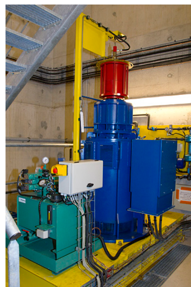
Barrage : vue plongeante sur le groupe de restitution.
