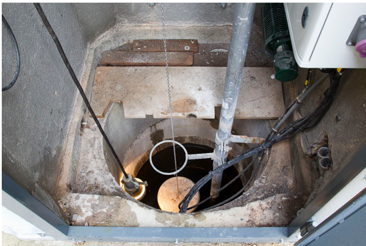
Prise d'eau : puits limnimétrique (utilisé pour mesurer le niveau de l'eau).
