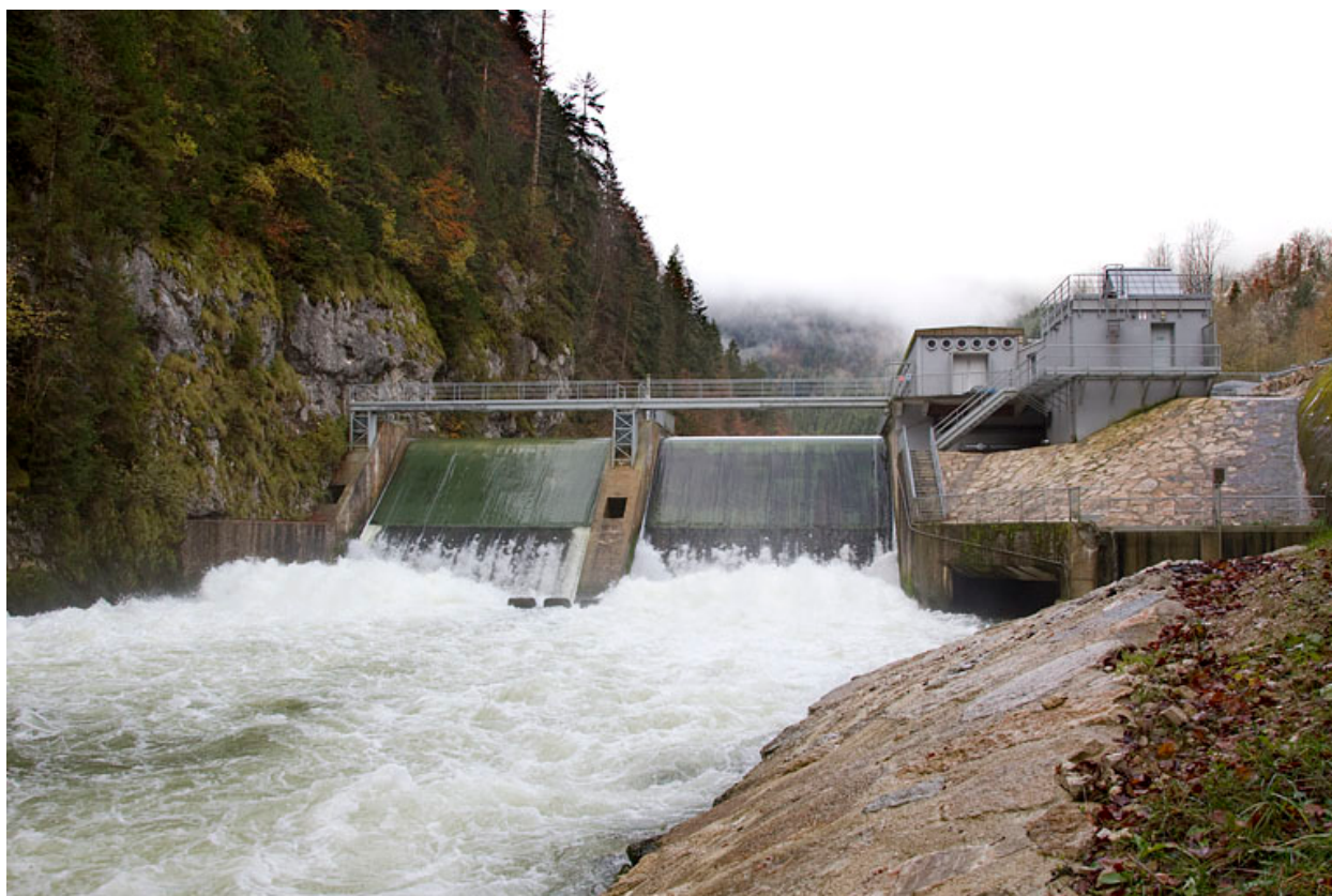
Barrage, vu d'aval.
