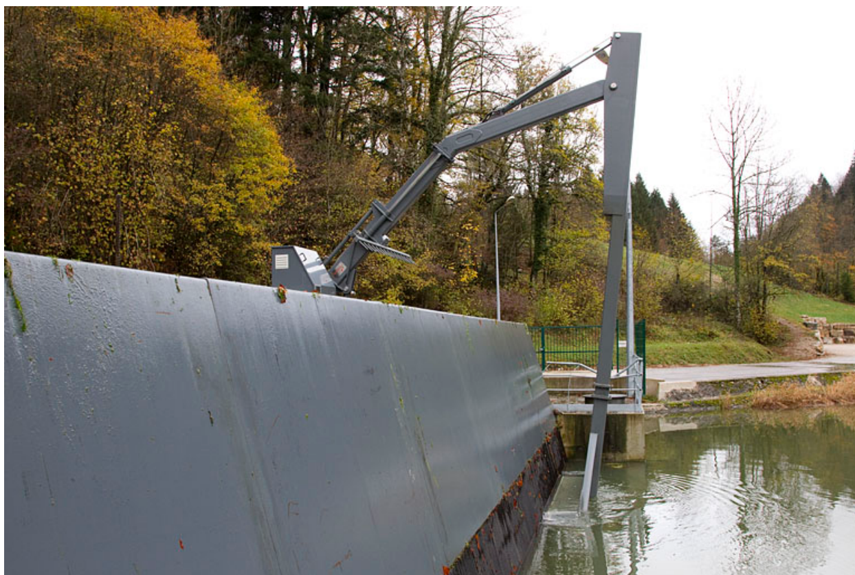
Prise d'eau : dégrilleur en fonctionnement.
