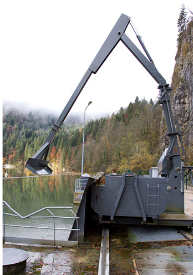
Prise d'eau : dégrilleur automatique (utilisé pour le nettoyage des grilles de protection). Phot. Yves Sancey IVR43_20122502087NUC2A
