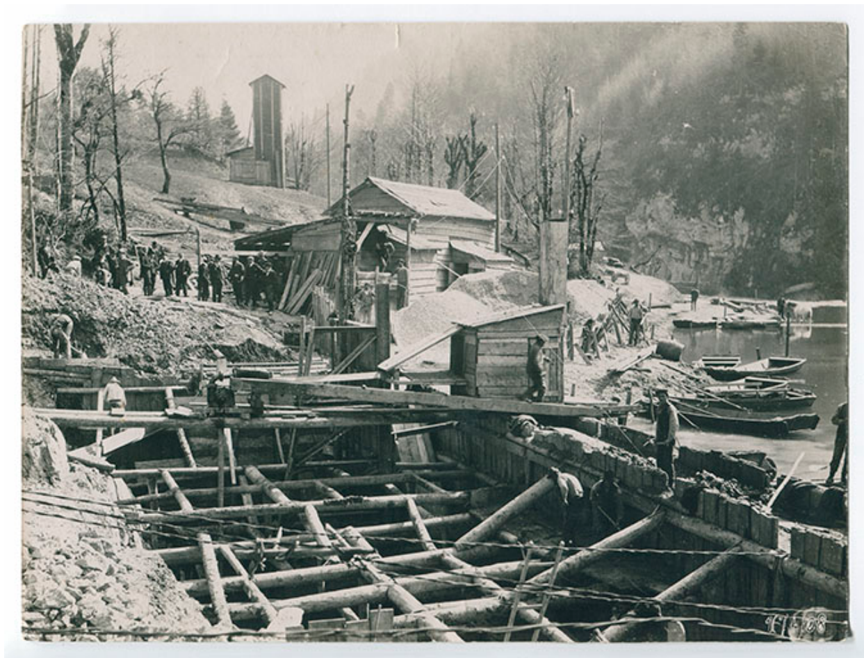
[Construction de la prise d'eau], [vers 1908].
