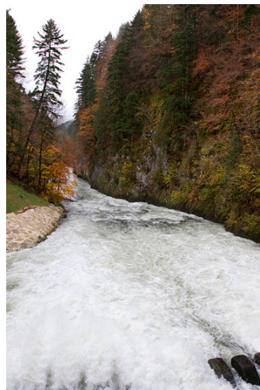
Le Doubs en aval des vannes toit. Phot. Yves Sancey IVR43_20122502107NUC2A
