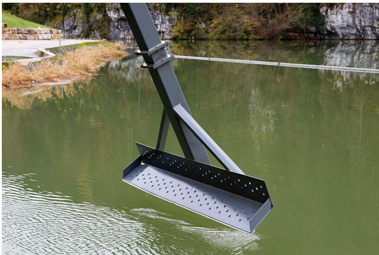
Prise d'eau : extrémité du bras du dégrilleur.
