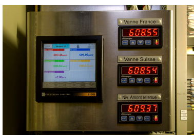
Barrage : cadran numérique de contrôle du fonctionnement des vannes et du niveau de la retenue.
