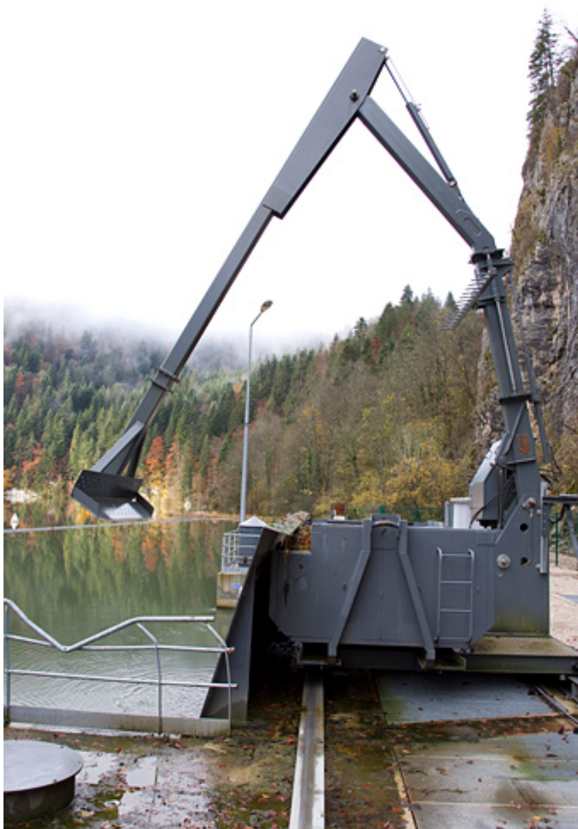
Prise d'eau : dégrilleur automatique (utilisé pour le nettoyage des grilles de protection).
