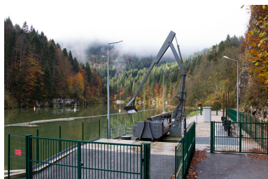
Prise d'eau : vue d'ensemble. Phot. Yves Sancey IVR43_20122502086NUC2A
