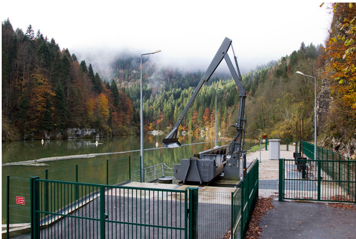
Prise d'eau : vue d'ensemble.
