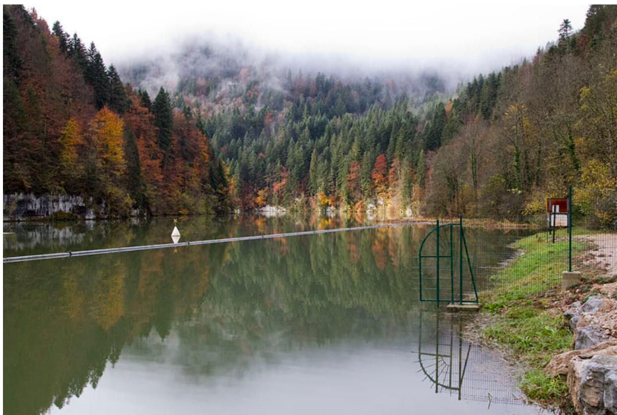
Le bassin de retenue, depuis le nord-est.
