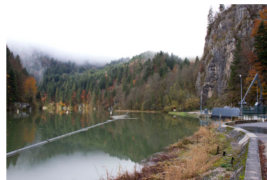
Bassin de retenue et ouvrage de prise d'eau. Phot. Yves Sancey IVR43_20122502085NUC2A
