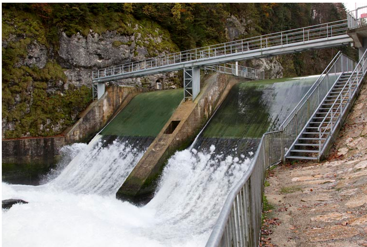
Barrage vu de trois quarts, depuis l'aval.
