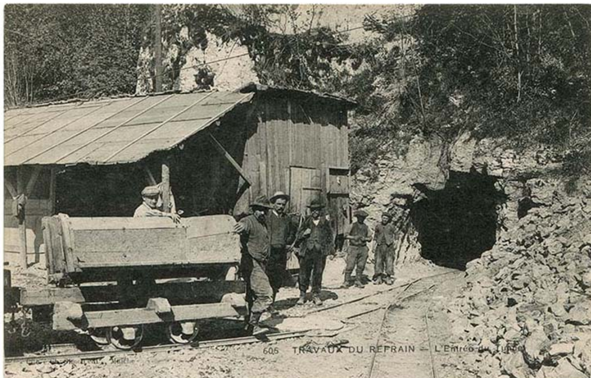
605. Travaux du Refrain - L'entrée du tunnel, vers 1908.
