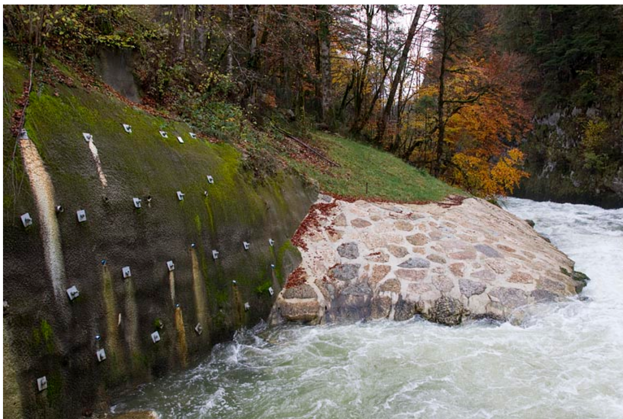
Berge renforcée en aval des vannes toit.
