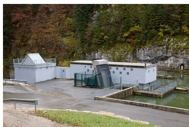
Barrage : prise d'eau et salle des machines (centrale du groupe de restitution) au premier plan, salle de commande des vannes toits à l'arrière-plan. Phot. Yves Sancey IVR43_20122502100NUC2A
