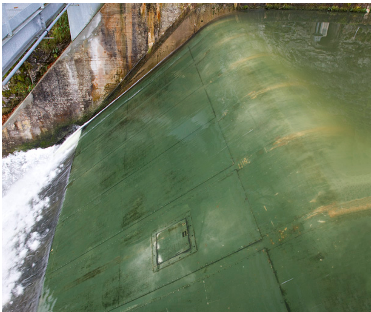
Barrage : une vanne toit.
