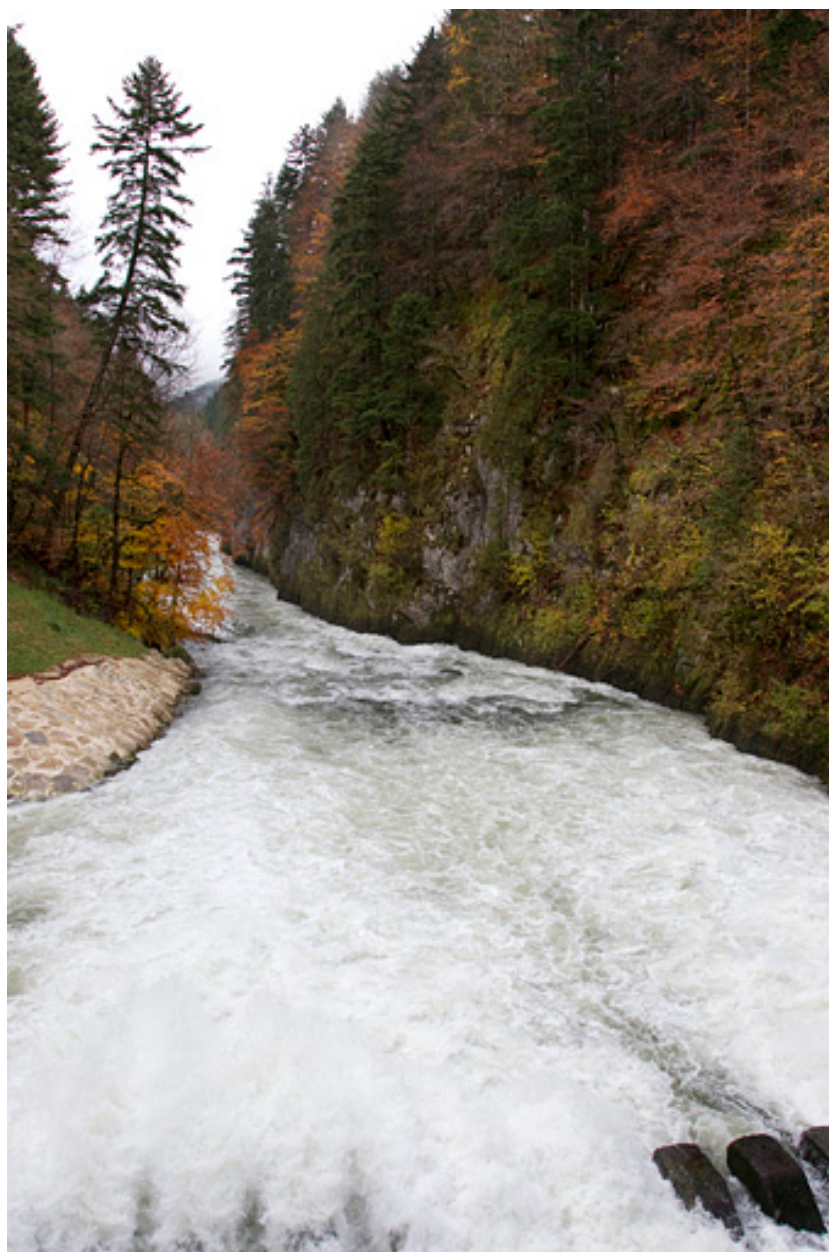
Le Doubs en aval des vannes toit.
