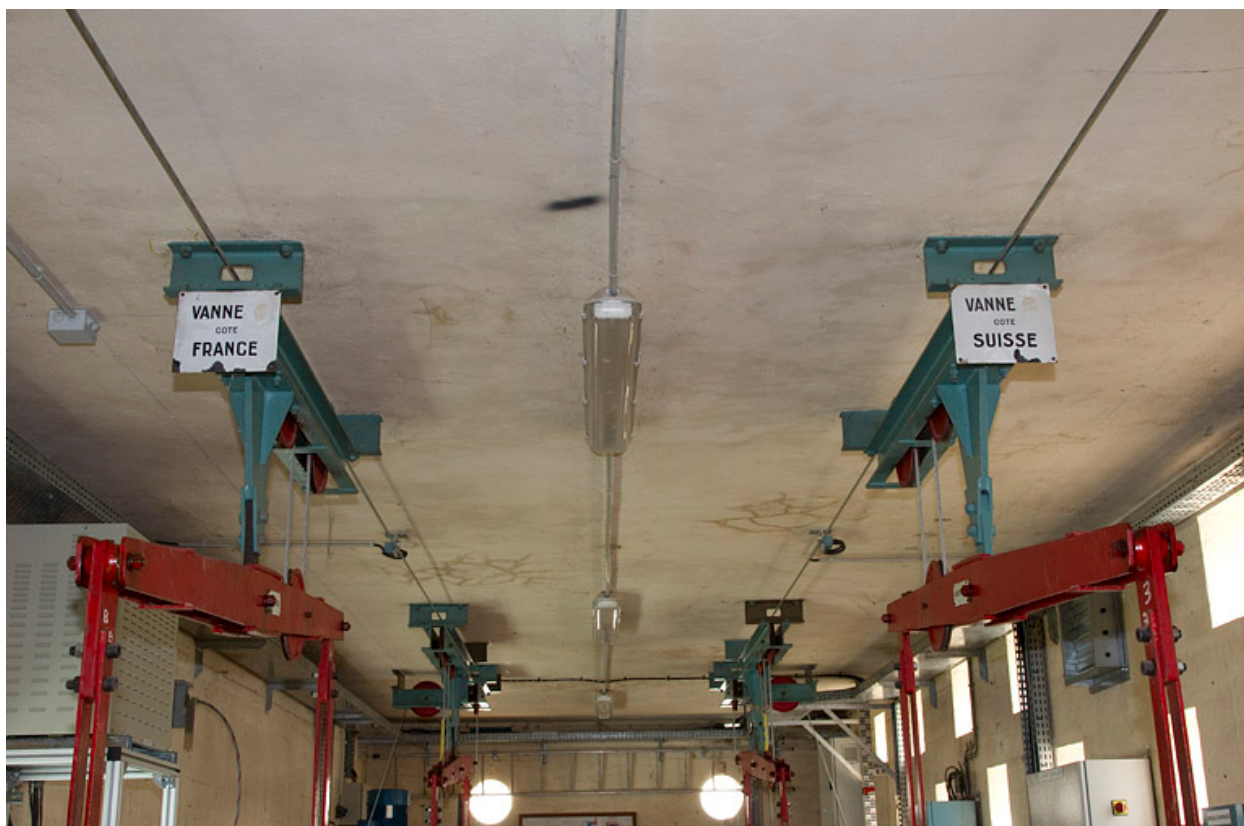
Barrage : repérage des vannes toit.
