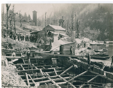
[Construction de la prise d'eau], [vers 1908]. Autr. auteur inconnu IVR43_2017250004NUC4A
