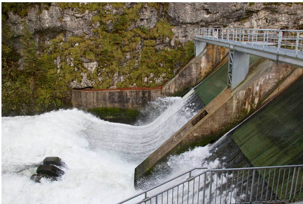
Barrage : vue plongeante sur les vannes toit.
