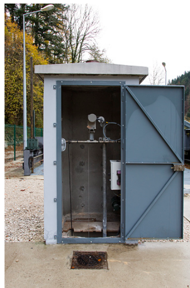
Prise d'eau : édicule et puits limnimétrique. Phot. Yves Sancey IVR43_20122502091NUC2A
