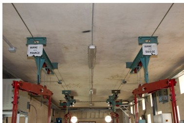
Barrage : repérage des vannes toit.
