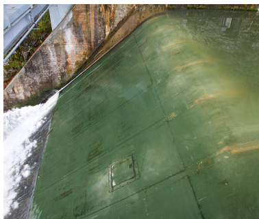
Barrage : une vanne toit. Phot. Yves Sancey IVR43_20122502078NUC2A
