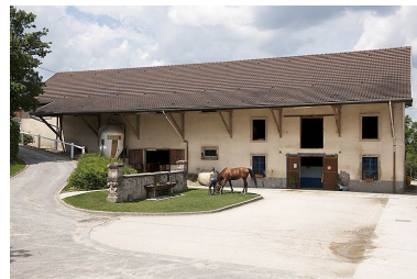
Ecurie et grange. Phot. Jérôme Mongreville IVR43_20112501618NUC4A
