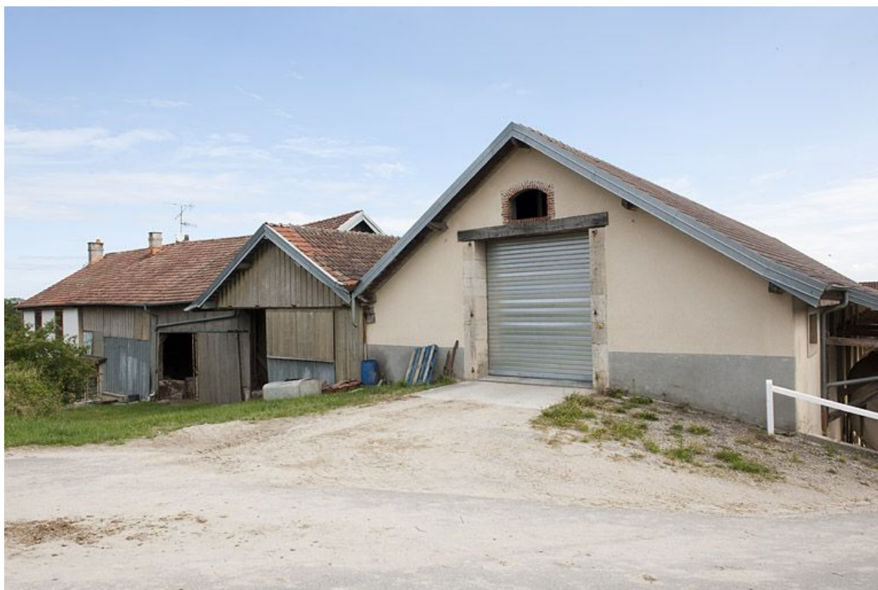
Pignons sud de l'écurie.
