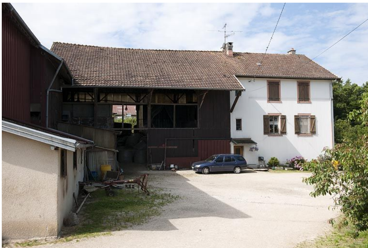
Second logement (extension ouest).
