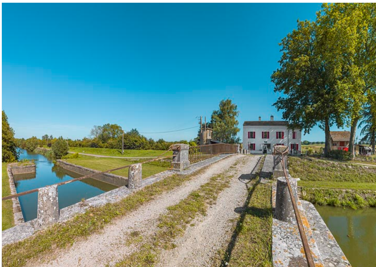
Le pont vu du dessus.
