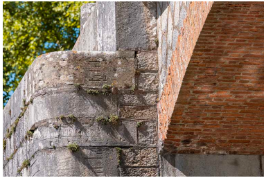
Détail de la voûte en brique et de l'échelle de crue sur la culée. Phot. Thierry Kuntz IVR26_20192100208NUC4A
