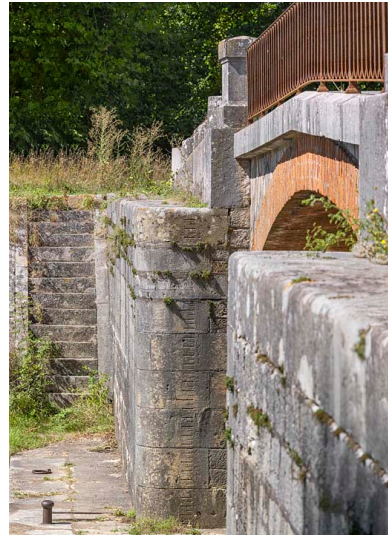
Détail de la voûte en brique, du garde-corps du pont et de l'échelle de crue sur la culée. Phot. Thierry Kuntz IVR26_20192100204NUC4A
