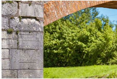
Détail de la voûte en brique et de l'échelle de crue sur la culée. Phot. Thierry Kuntz IVR26_20192100210NUC4A
