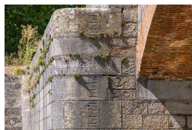
Détail de la voûte en brique et de l'échelle de crue sur la culée. Phot. Thierry Kuntz IVR26_20192100207NUC4A
