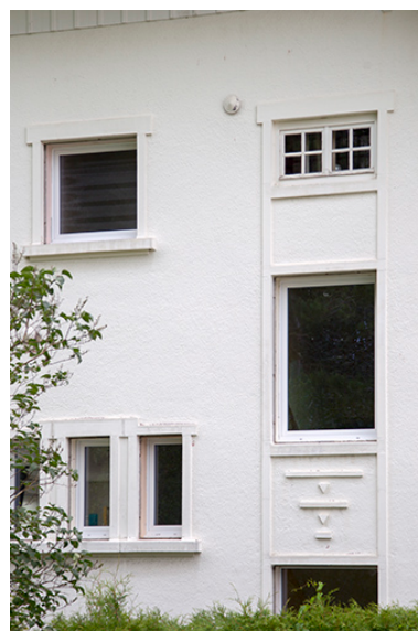
Façade postérieure : détail de baies. Phot. Sonia Dourlot IVR43_20152500961NUC2A
