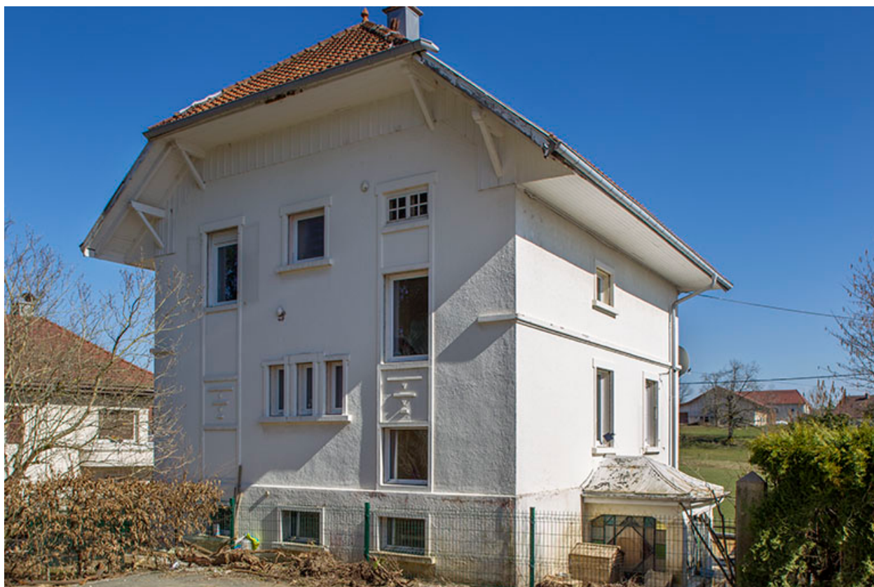
Façades postérieure et latérale gauche.
