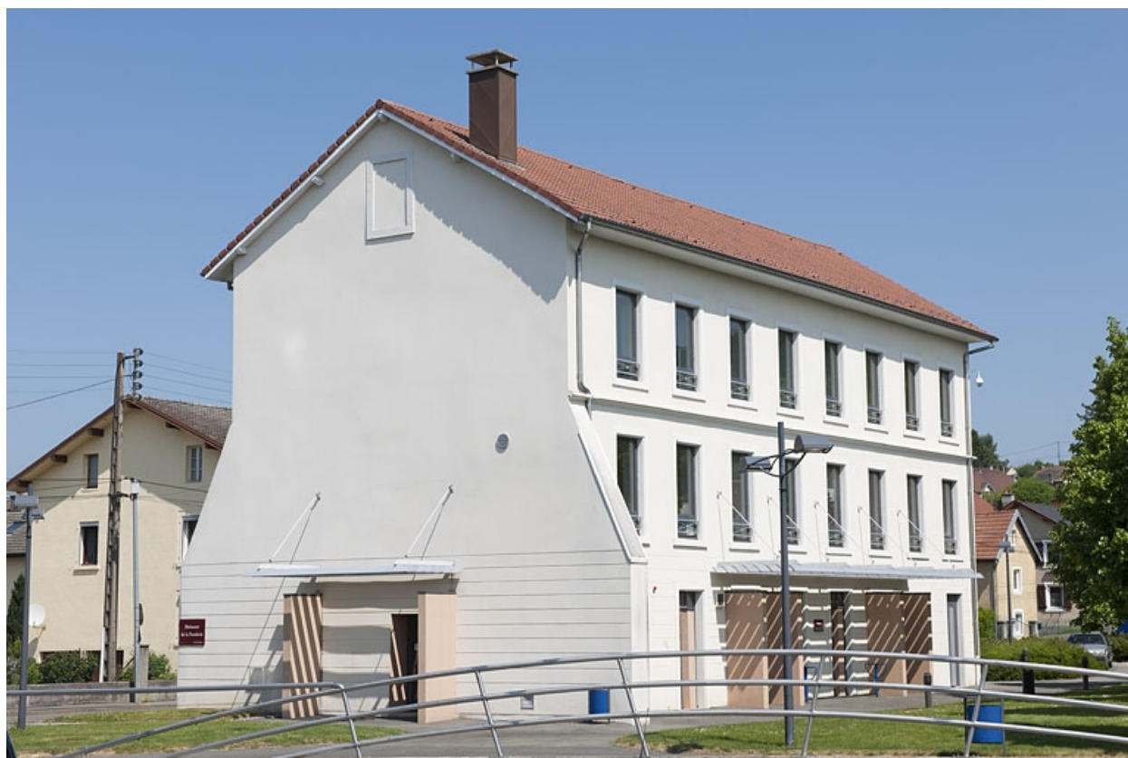
Bâtiment de bureaux. Vue trois quarts arrière.
