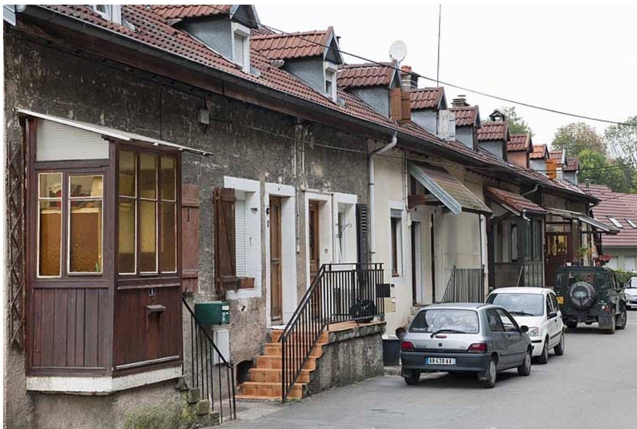
Façade est du logement sud (caserne B).
