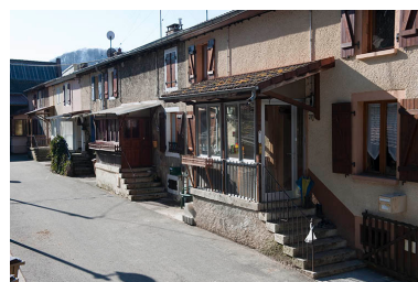
cité ouvrière Peugeot de Terre- Blanche, dite cité A et B Phot. Jérôme Mongreville IVR43_20122502230NUC4A
