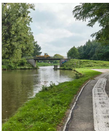
Vue d'ensemble du pont.
