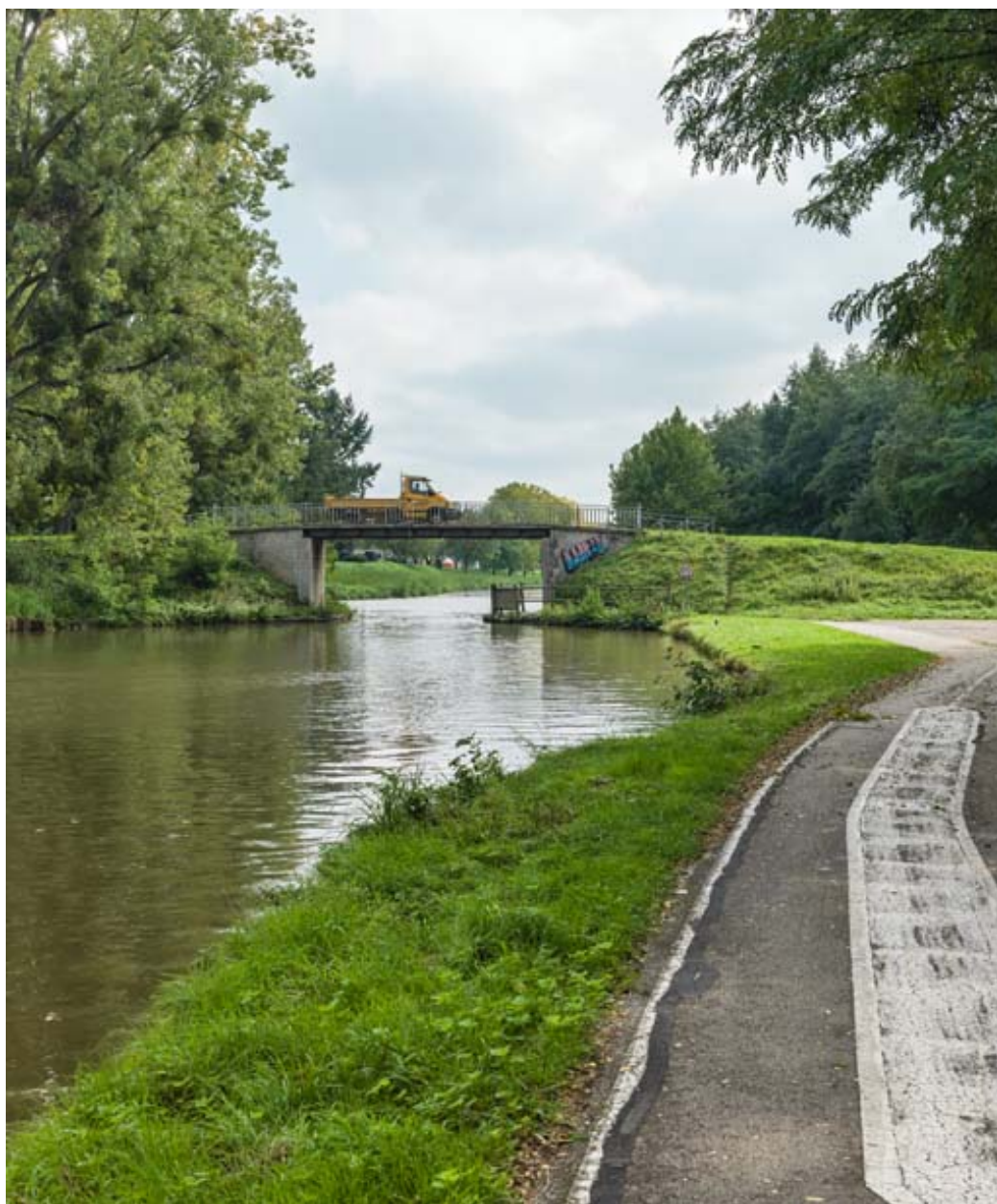
Vue d'ensemble du pont.
