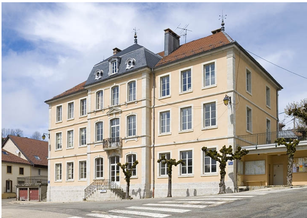
Façade antérieure et façade latérale droite.
