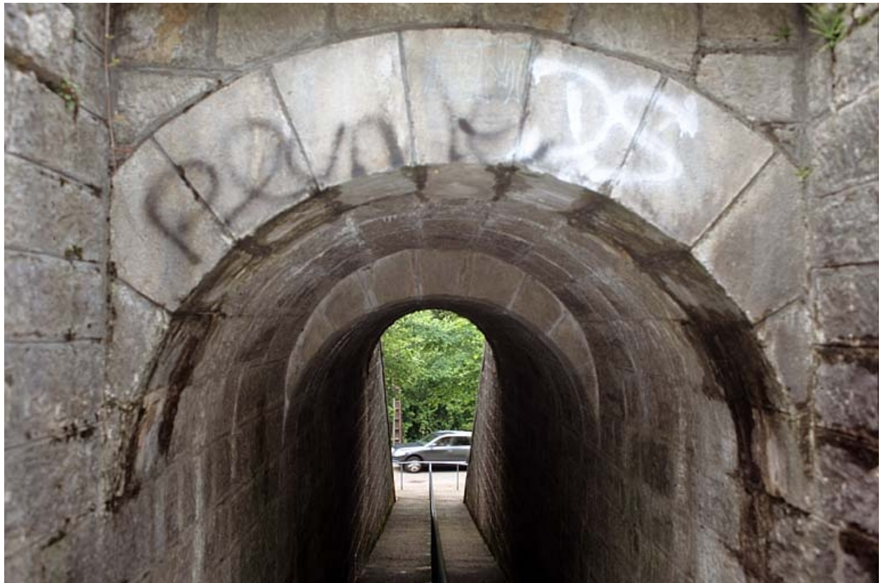
Voûte appareillée en rouleaux à ressauts, depuis l'amont (sud).
