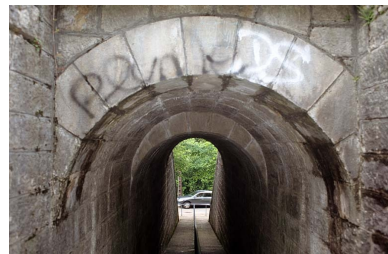
Voûte appareillée en rouleaux à ressauts, depuis l'amont (sud). Phot. Yves Sancey IVR43_20053900861ZA
