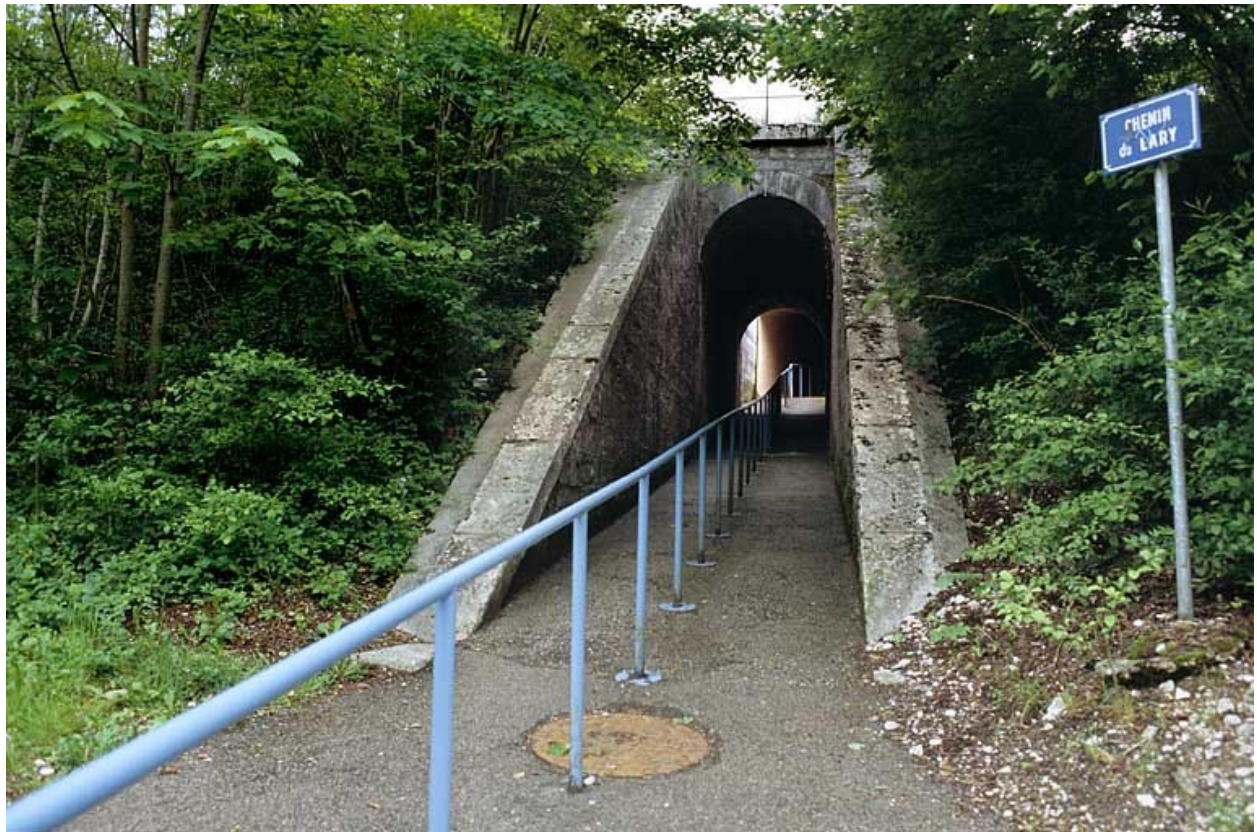
Vue d'ensemble de la tête aval (nord).
