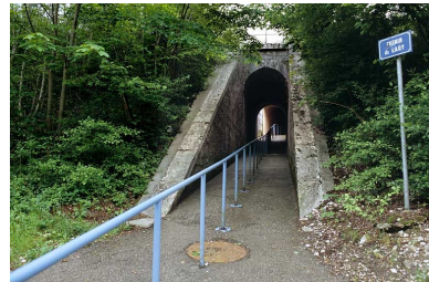
Vue d'ensemble de la tête aval (nord). Phot. Yves Sancey IVR43_20053900860ZA
