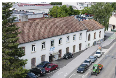
Vue plongeante sur le bâtiment administratif (?). Phot. Jérôme Mongreville IVR43_20122500960NUC4A
