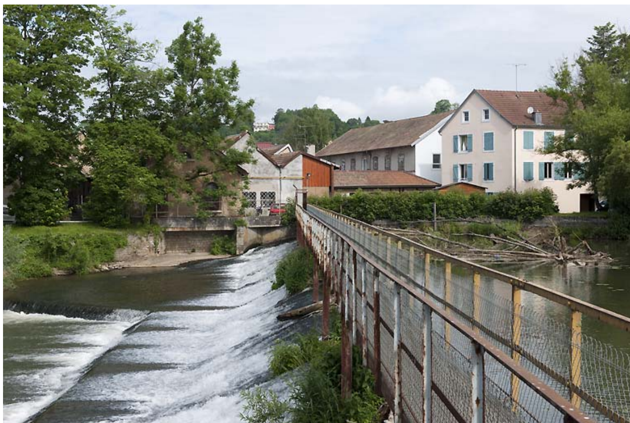
Vue d'ensemble depuis l'extrémité sud du barrage.
