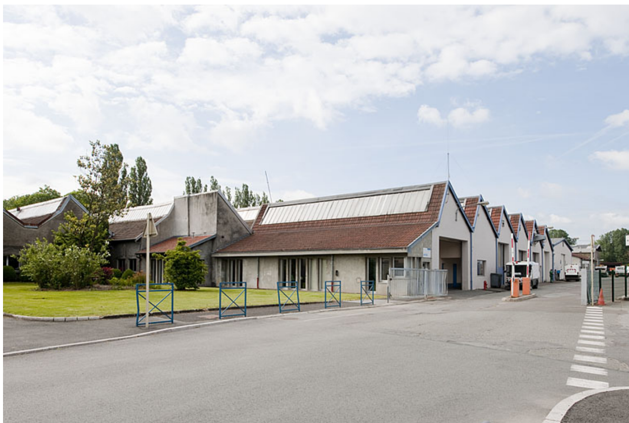
Entrée du site depuis la route.
