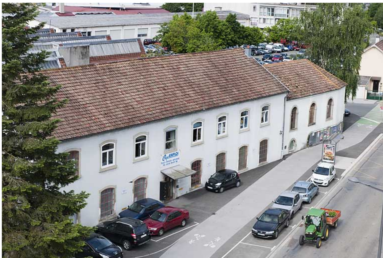
Vue plongeante sur le bâtiment administratif (?).
