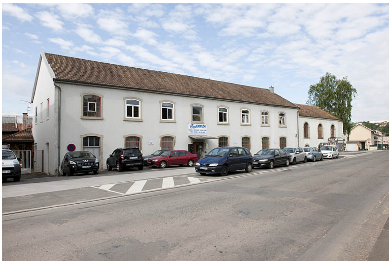
Bâtiment administratif (?) longeant le faubourg de Besançon.
