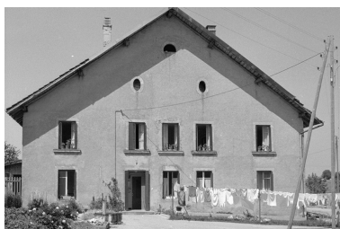
Ferme : façade antérieure. Phot. Gilbert Poinot IVR43_19752500804Z
