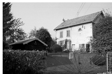
Maison située place du Souvenir. Phot. Bernard Lardière IVR43_19832500123Z
