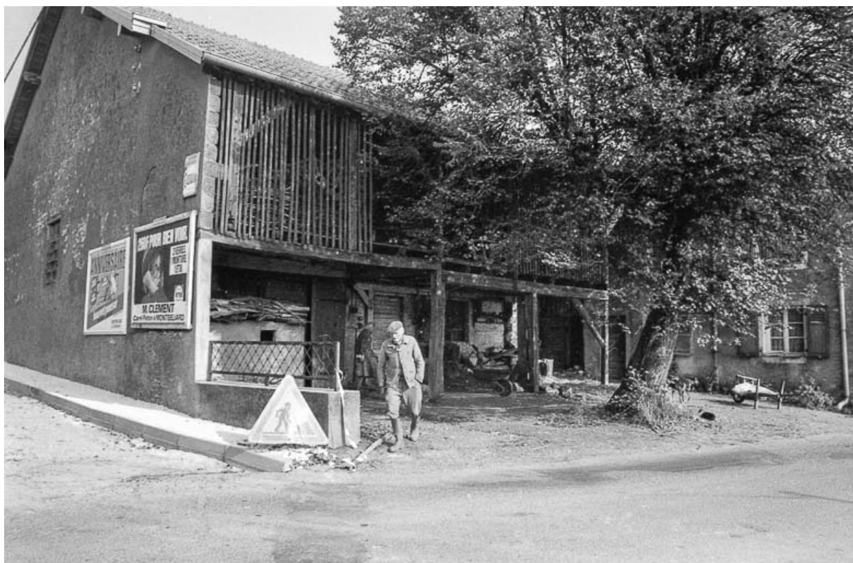
Ferme située Grande Rue.
