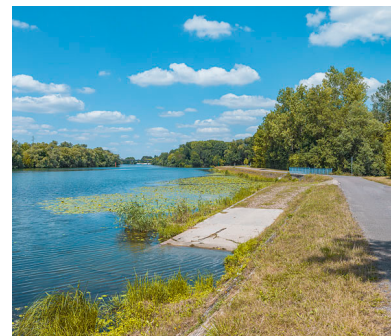
La rampe d'abreuvoir et les perrés. Phot. Thierry Kuntz IVR26_20192100168NUC4A
