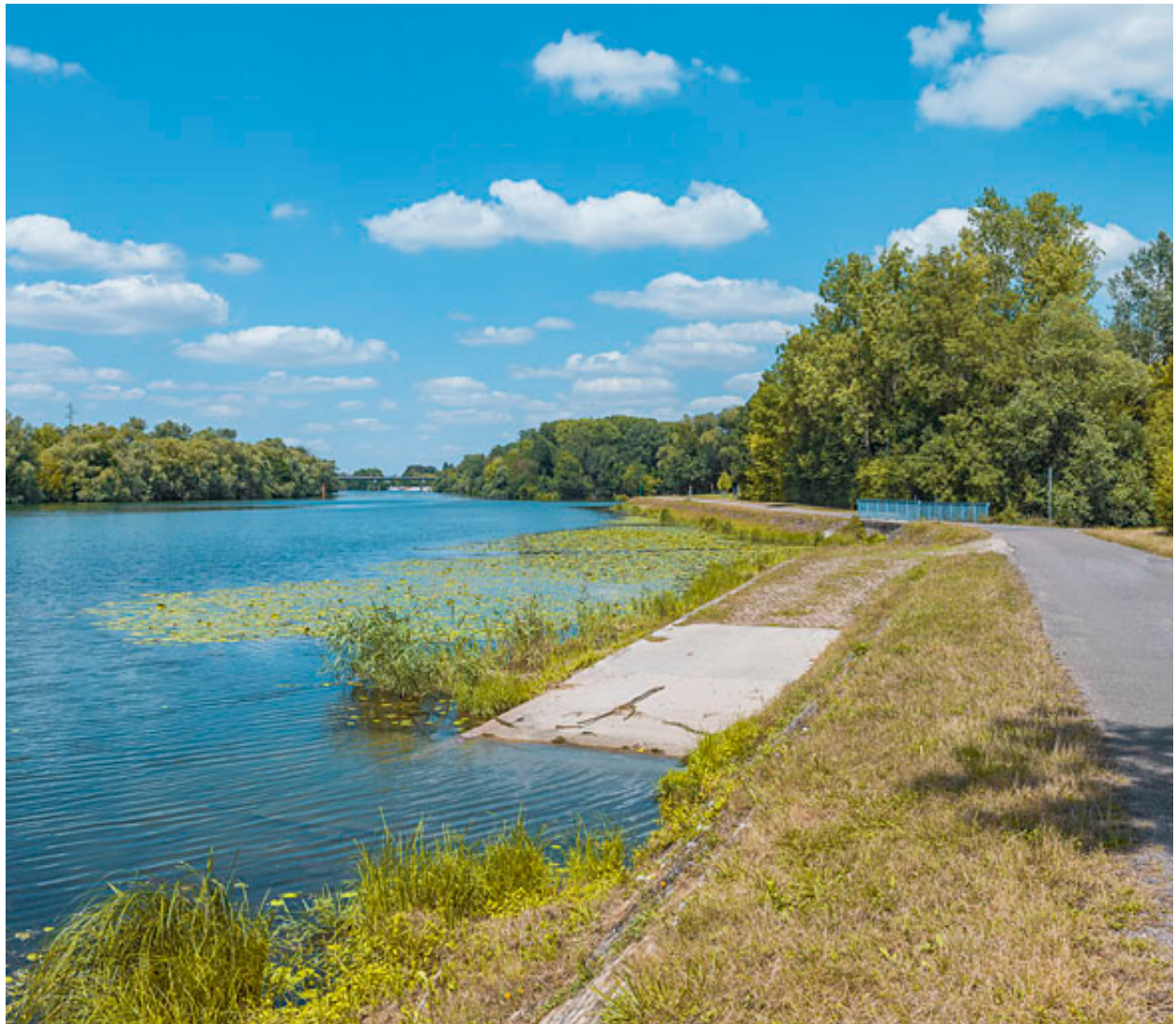
La rampe d'abreuvoir et les perrés.
