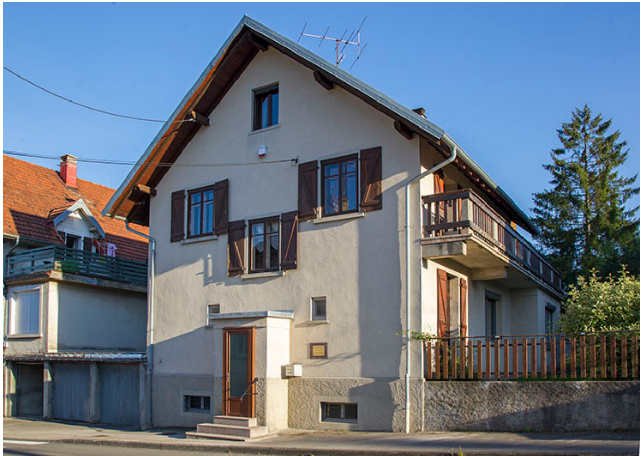
Façades antérieure et latérale droite.
