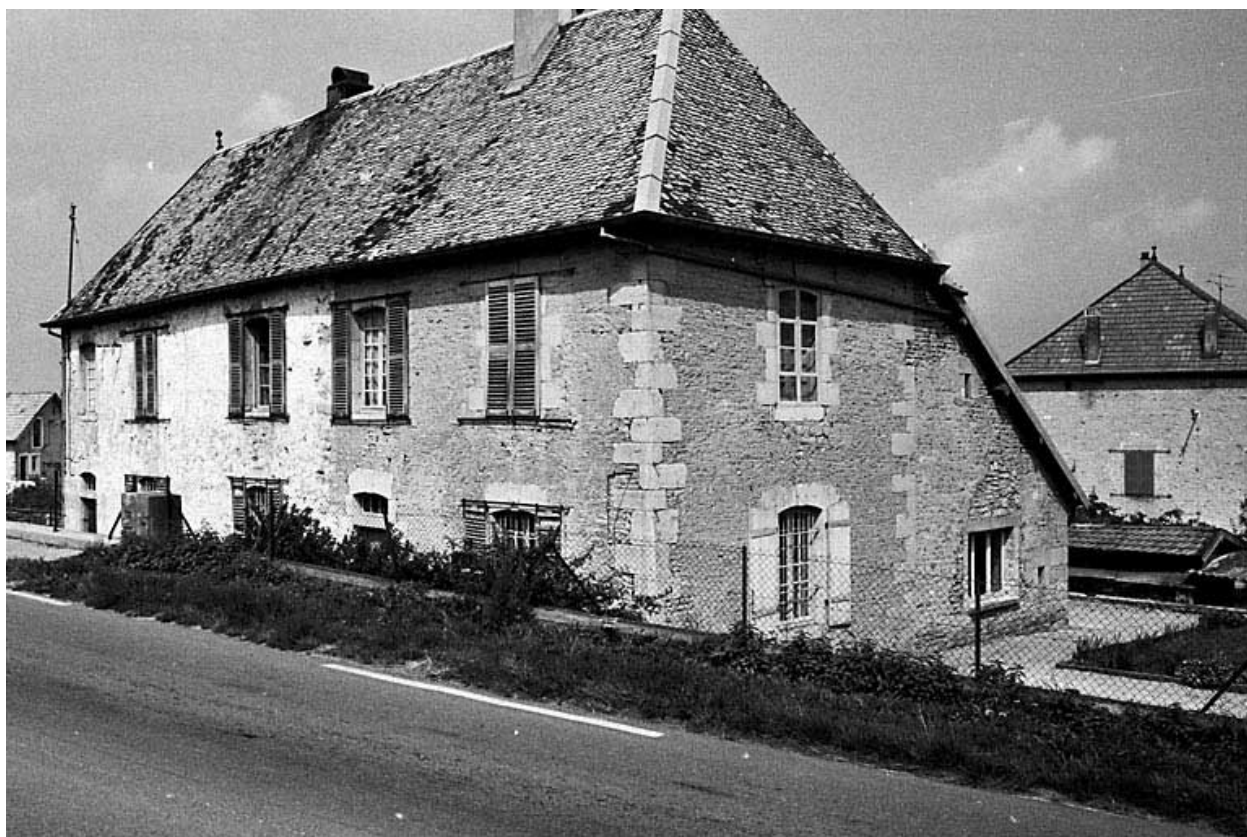
Façade antérieure et face latérale droite.
